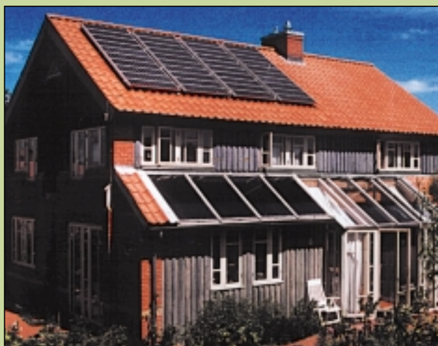
Abb. 1 Aktive und passive Sonnenenergienutzung
