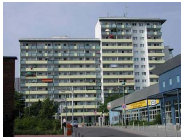
11- und 14-Geschosser (Einrohrheizung)
