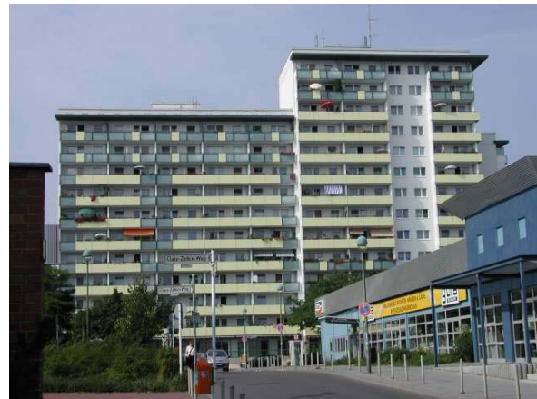
11- und 14-Geschosser (Einrohrheizung)
