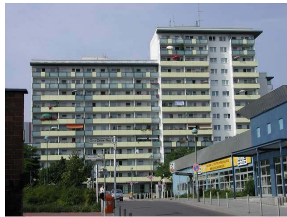
11- und 14-Geschosser (Einrohrheizung)
