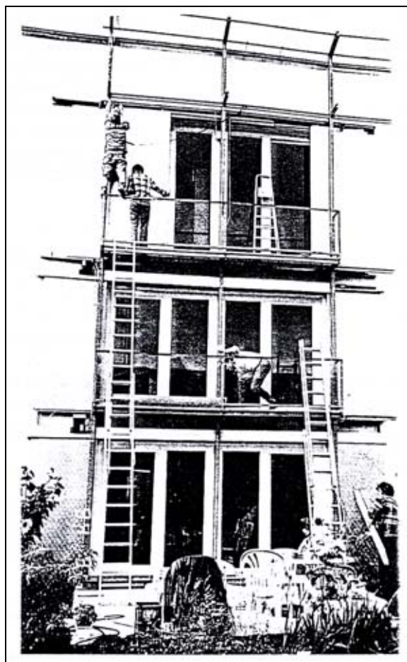
Bild 6. Montage der Dämmschiebeläden an der Fassade des westlichen Passivhauses (Haus IV), Ende 1994 (Die aus beidseitig aluminiumkaschierten Polyurethanplatten bestehenden Schiebläden werden nachts motorisch geschlossen und reduzieren so den Fenster-k-Wert auf < 0,3\text{ W/m}^2\text{K} .)
