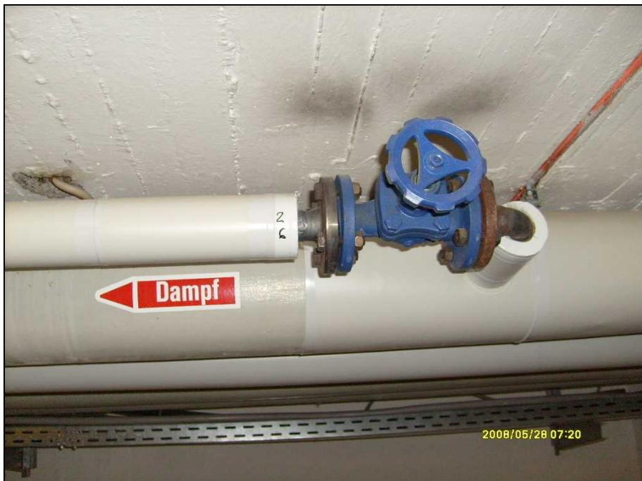
**Bild 34 Neu verlegte Niederdruckdampfleitung unter Küche**
