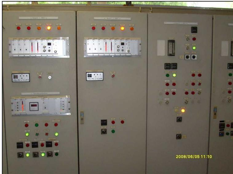
**Bild 5 Schaltschrank der Dampftechnik mit Wasserstandsregler und Füllstandsanzeigen für Kessel und Speiswasserbehälter**
