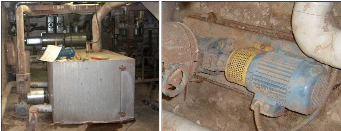
**Bild 20 Kondensatbehälter und Kondensatpumpe in der Küche**
