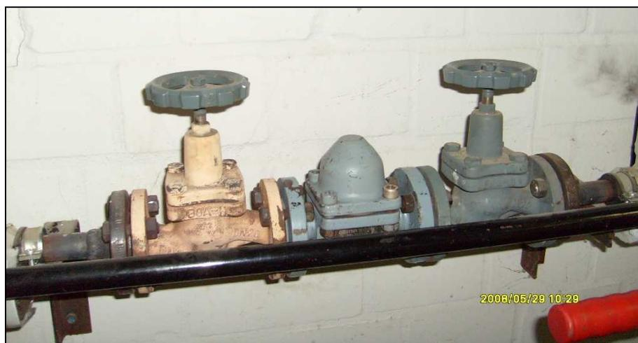
**Bild 18 Undichter Kondensatableiter im Wäschereikeller**
