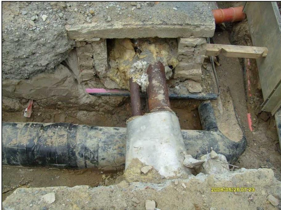
**Bild 31 Ursprüngliche Hauptleitung (oben verlaufend) und neue Hauptleitung aus 2000/01 (unten verlaufend)**
