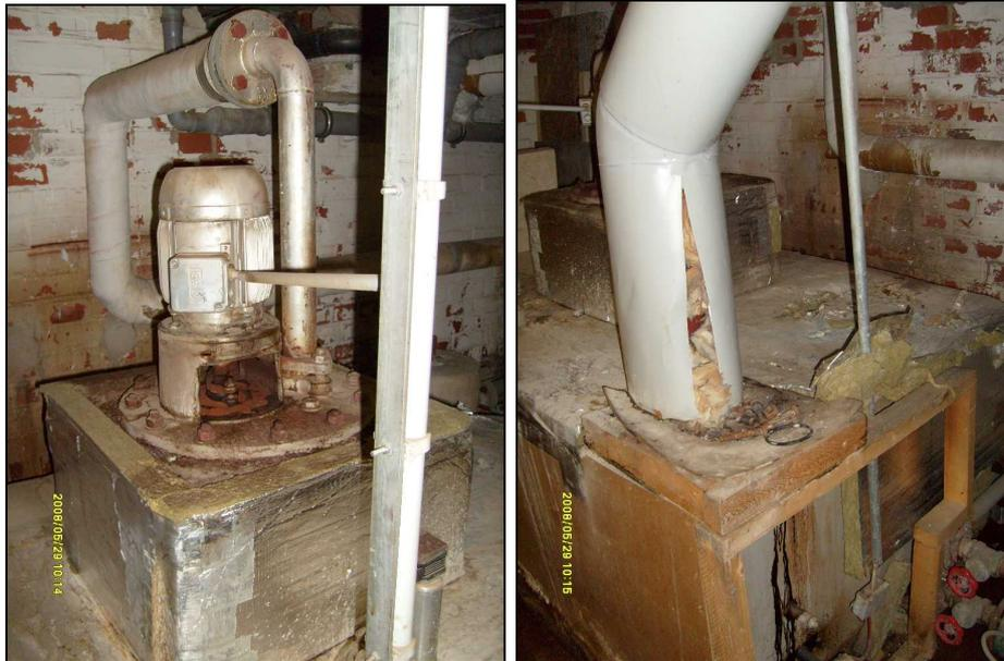
**Bild 19 Kondensatbehälter mit Pumpe in der Wäscherei**
