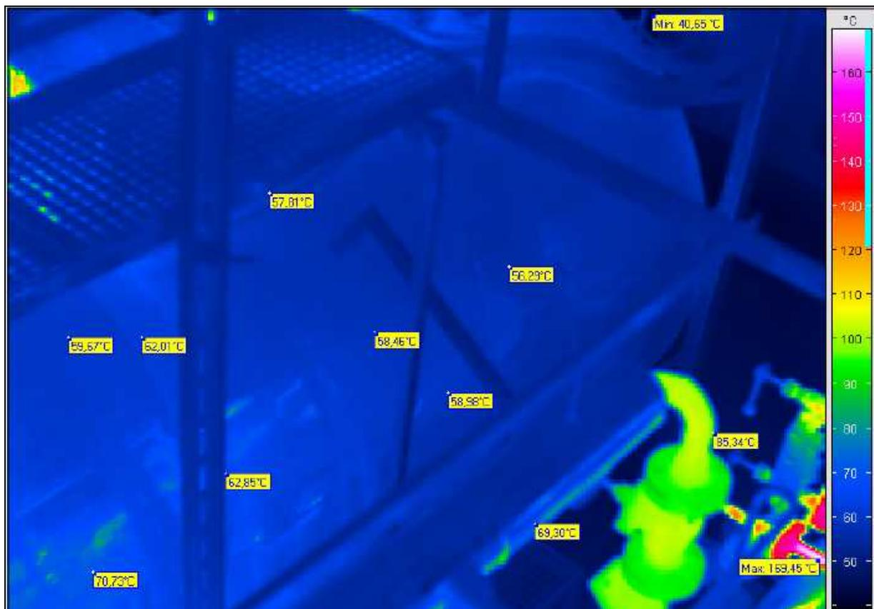
**Bild 7 Thermographieaufnahmen am Dampfkessel II (Oberfläche)**
