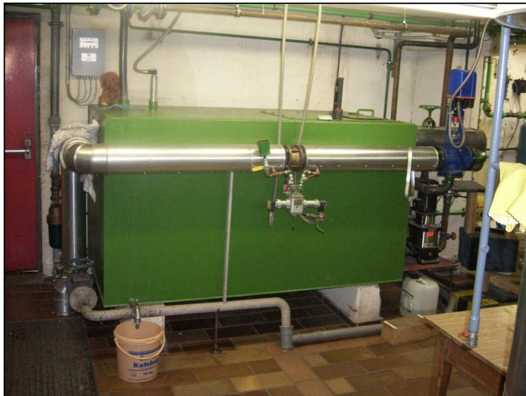
**Bild 15 Kondensatbehälter im Kesselhaus**
