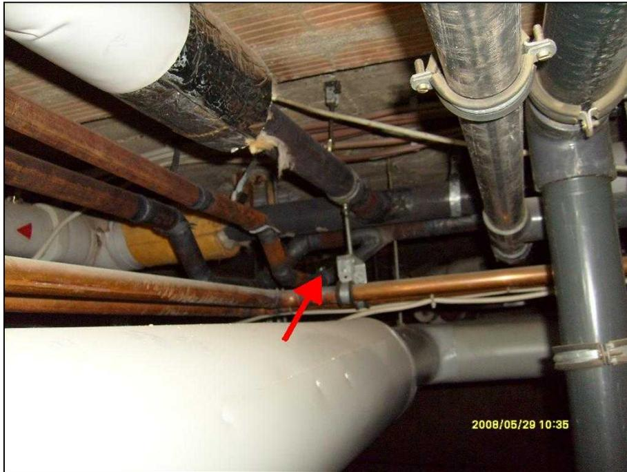
**Bild 41 Ungedämmte und provisorisch gedichtete Leitungen**
