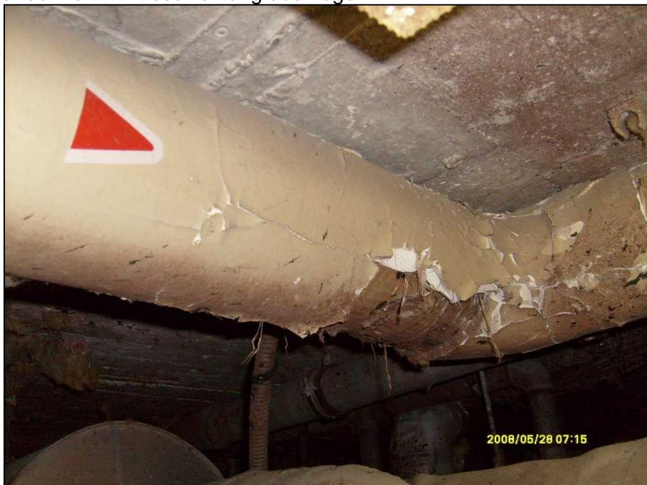
Bild 32 Zustand der Gebäude-Hauptzuleitung in der Küche (alter Rohrabschnitt).
