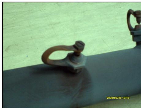
**Bild 10 Entgaserdüsenstock**
