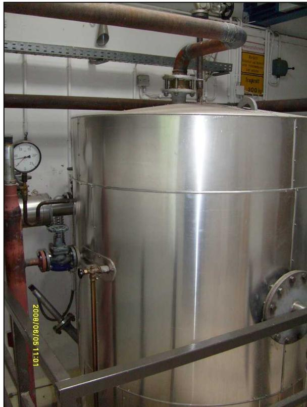
**Bild 12 Oberer Bereich des Umlauf-Sprüh-Entgasers**
