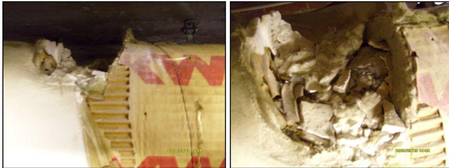
**Bild 33 Zustand einiger wärmegeämmter Leitungen im Wäschereikeller**
