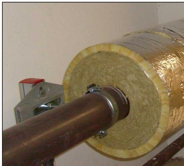
**Bild 39** Neu verlegte Hauptzuleitung zur Wäscherei
