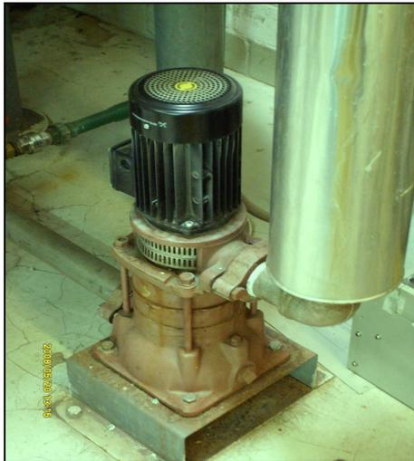
**Bild 13 Entgasungspumpe**
