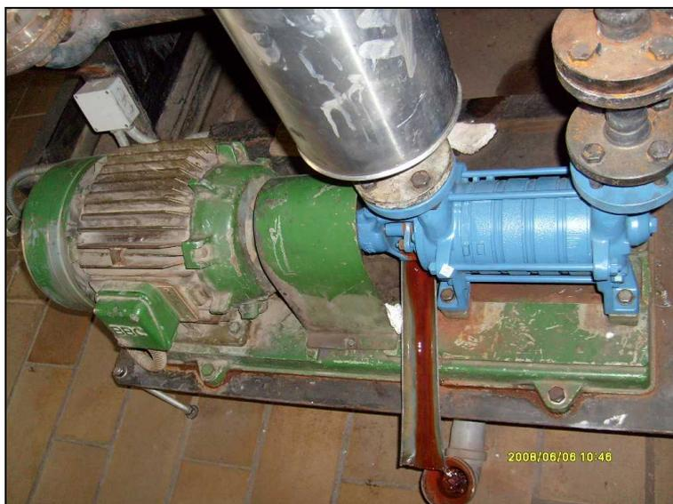
**Bild 14 Speisewasserpumpe mit Elektromotor und Dichtmanschettenentwässerung**
