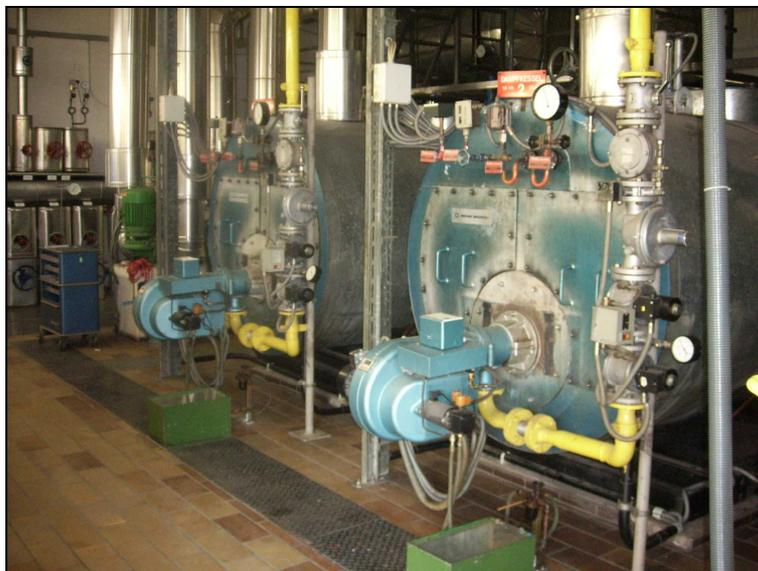
**Bild 6 Dampfkessel mit modulierenden Elco Zweistoffbrennern**
