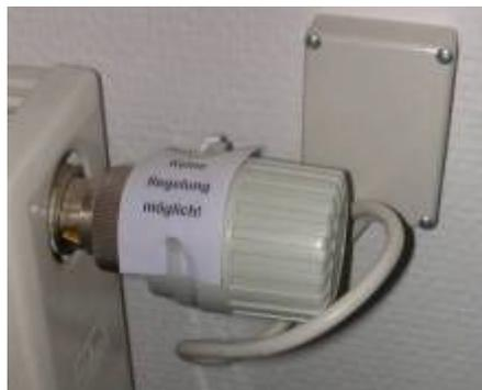
elektronischer Regler mit motorischem Antrieb (PI),
