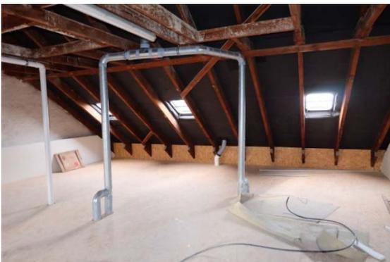
Abbildung 95 Grundriss Wohnung Hi-E36 mit Abluftanlage. Foto unten: Fortluftführung im DG
