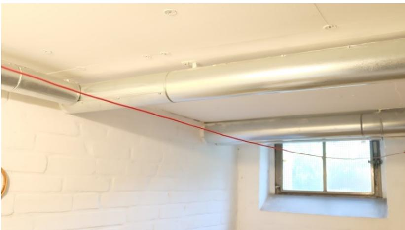
Abbildung 93 Dämmung der Kellerdecke von unten in Stöcken, unterseitig Gipsfaser-Bekleidung, Foto: Unverzagt
