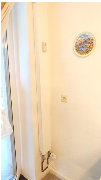
Abbildung 31 Heizkörper nach Balkontüreinbau in der Küche (Foto: Unverzagt)
