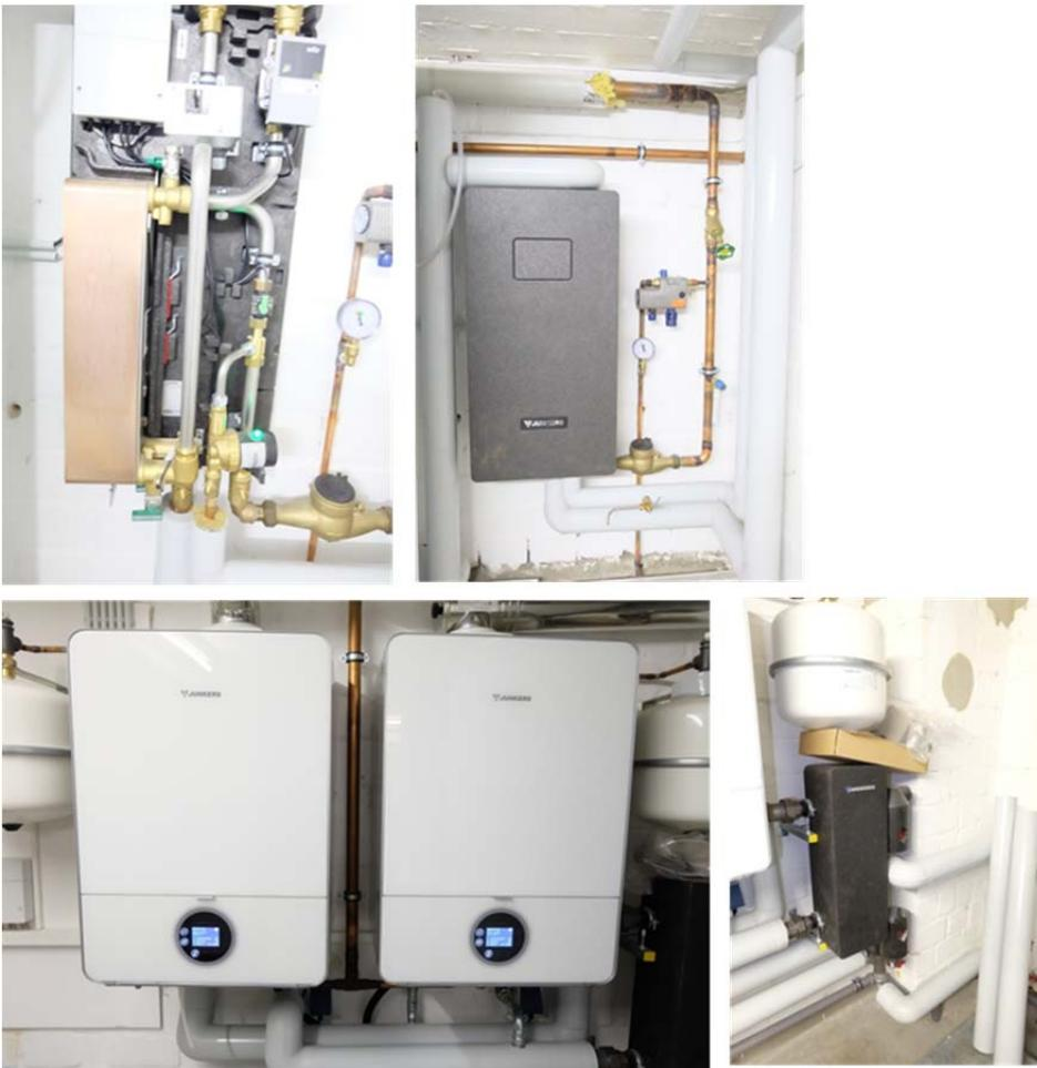
Abbildung 44 Heizungserneuerung BS-B20-22, Junkers-Gasthermen, unten rechts: hydraulische Weiche, Fotos oben: Frischwasserstation, Fotos: Unverzagt
