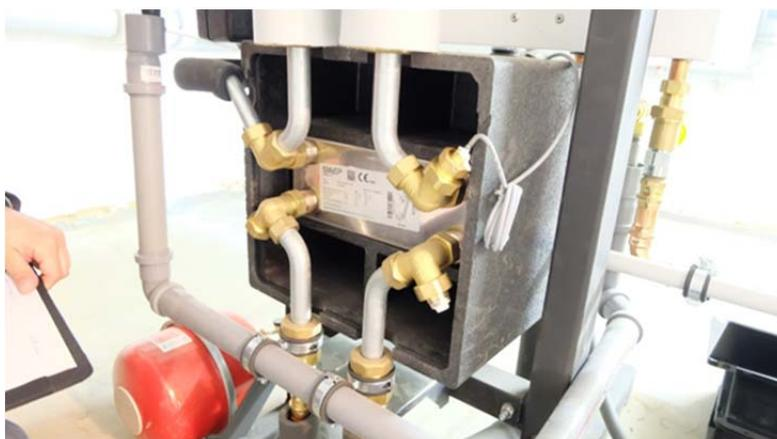
**Abbildung 24 Wärmeübertrager Objekt H-H9-11 zur Trennung von Sekundärkreis und Kessel (Foto Unverzagt)**
