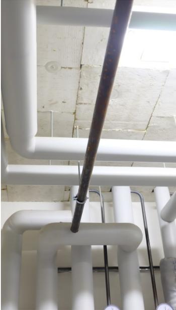
**Abbildung 80 Wärmebrückeneffekt am Abweig zum Ausdehnungsgefäß: Zur Vermeidung von Wärmeabgabe wäre eine flankierende Dämmung sinnvoll.**
