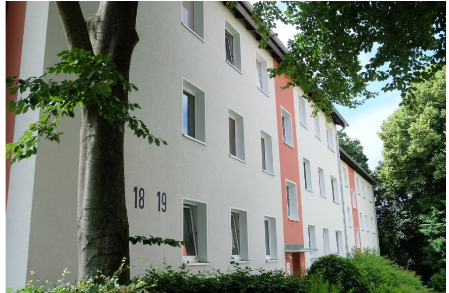
Nach der Modernisierung: 14 cm Wärmedämmverbundsystem
