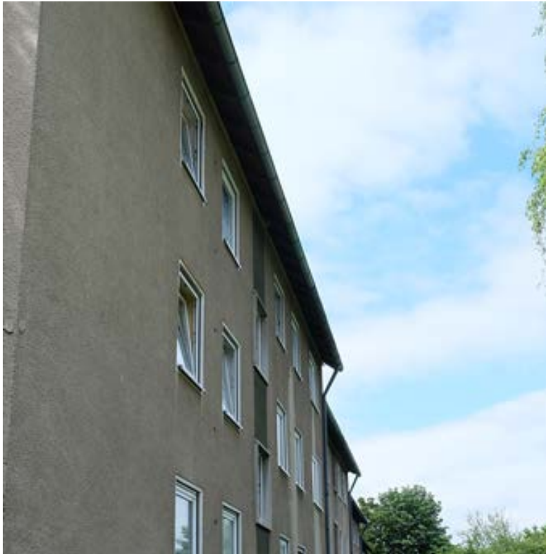
Vor der Modernisierung: Bestandsmauerwerk 1964
