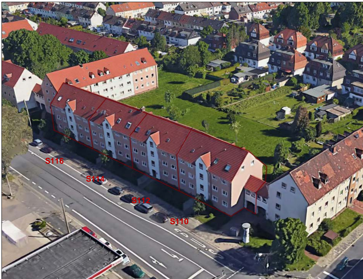
Abbildung 1 Blockbebauung 4 MFH BJ ca. 1930
