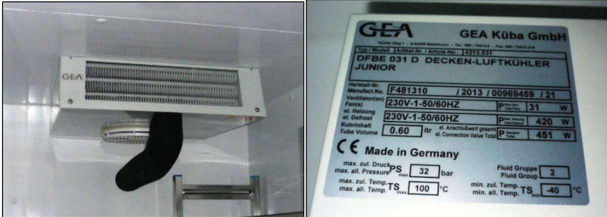
Abbildung 7-53: Inneneinheit der Kältemaschine
