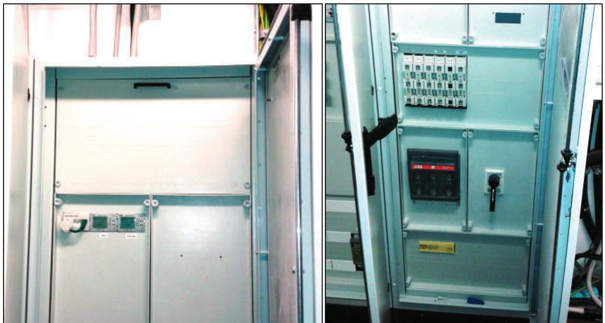
**Abbildung 3-14: Elektroverteilung – Unterzähler Hort und Küche mit Sicherungen**
