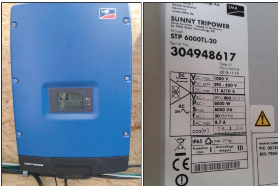
Abbildung 3-27: Wechselrichter Sunny Tripower und Typenschild
