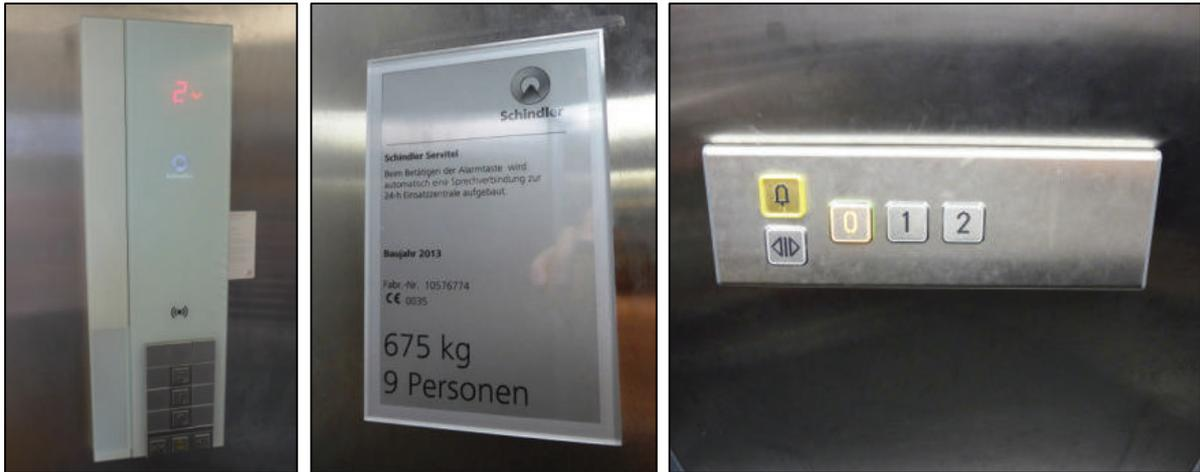
**Abbildung 7-92: Bedienpaneel und Typenschild**
