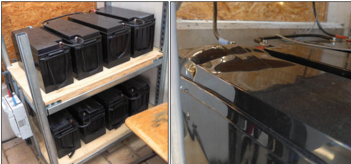
**Abbildung 3-33: Komplettbatterie Bleigel mit Schadensfall rechts**
