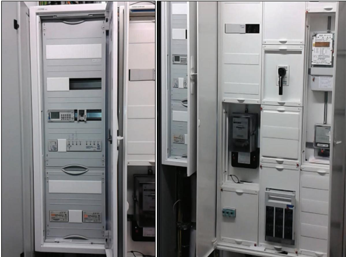
Abbildung 3-15: Elektroverteilung – Zentrale Zeitsteuerung sowie Hauptstromanschluss
