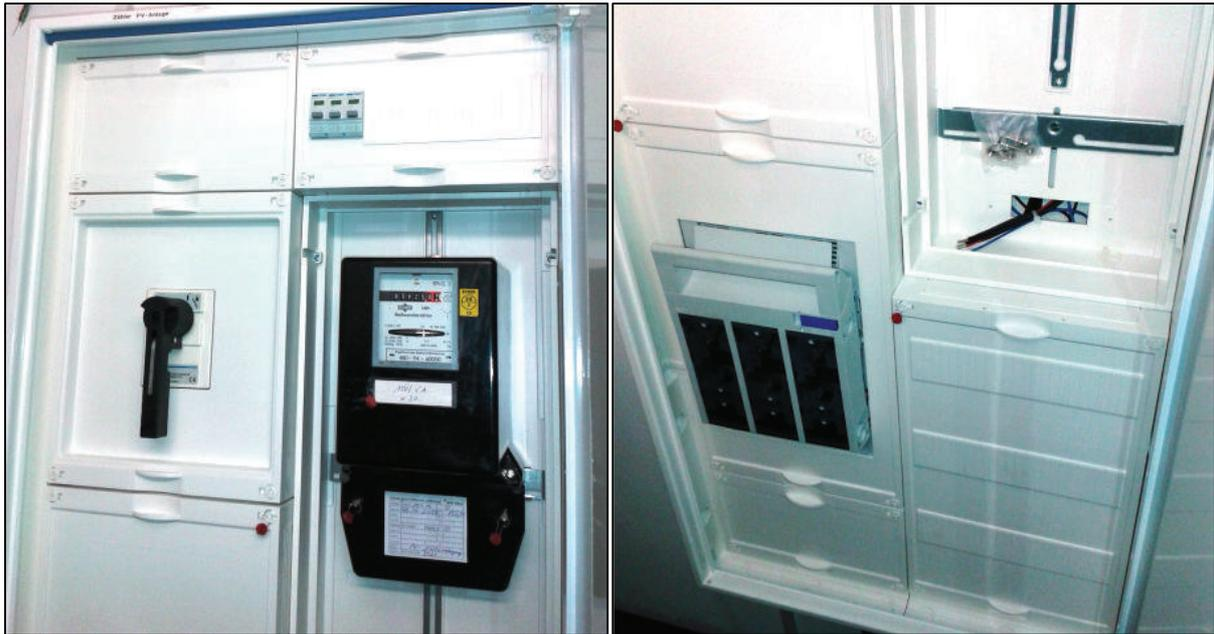
**Abbildung 3-11: Elektroverteilung – PV Einspeisezähler**
