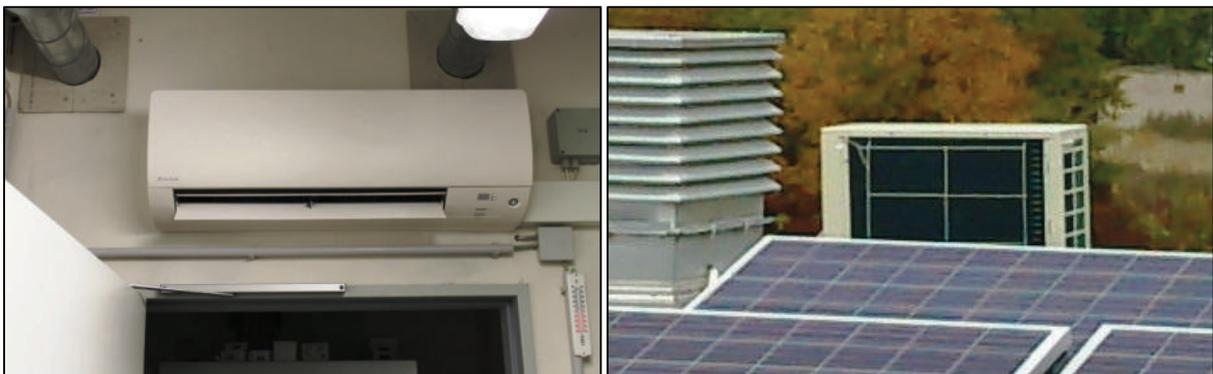
Abbildung 7-74: Innen- und Außeneinheit der Serverkühlung
