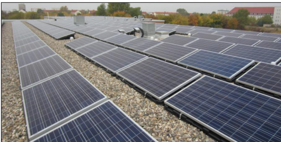
Abbildung 1-1: Photovoltaikanlage auf Dach
