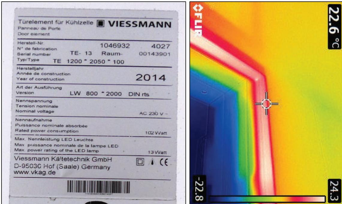
Abbildung 7-60: Elektrische Türrahmenheizung
