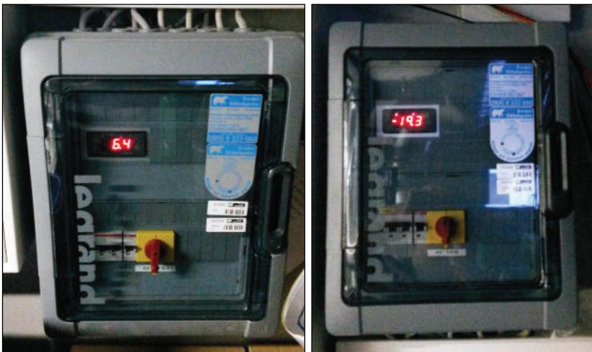
Abbildung 7-58: Regelung der Kühl- und Tiefkühlzelle in Raum 0.30
