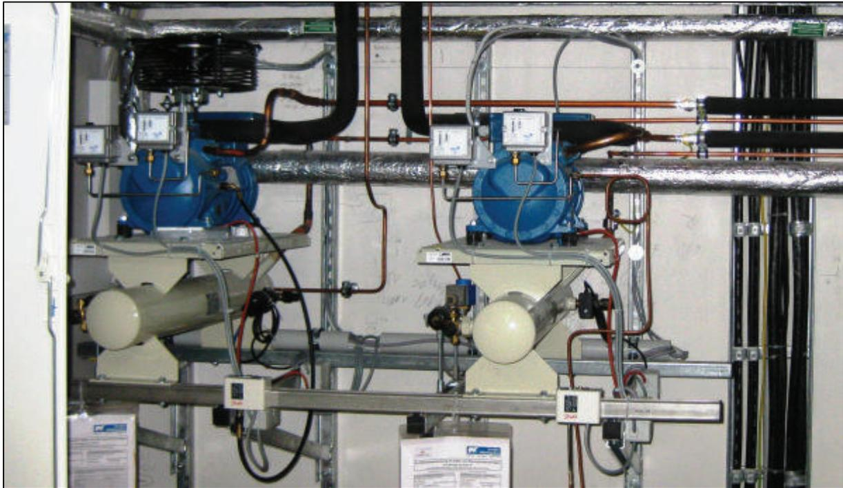
Abbildung 7-54: Kompressoren der beiden Kälteanlagen in Raum 0.30
