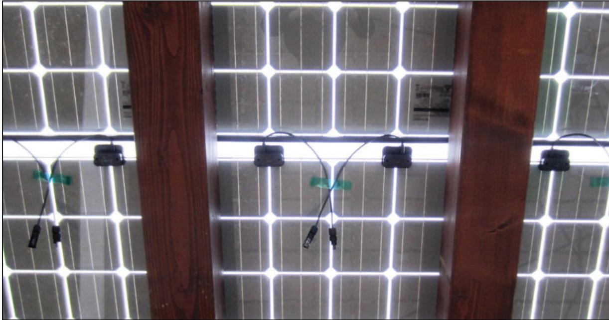
Abbildung 3-25: Photovoltaik-Module als Dacheindeckung – während der Installationsphase
