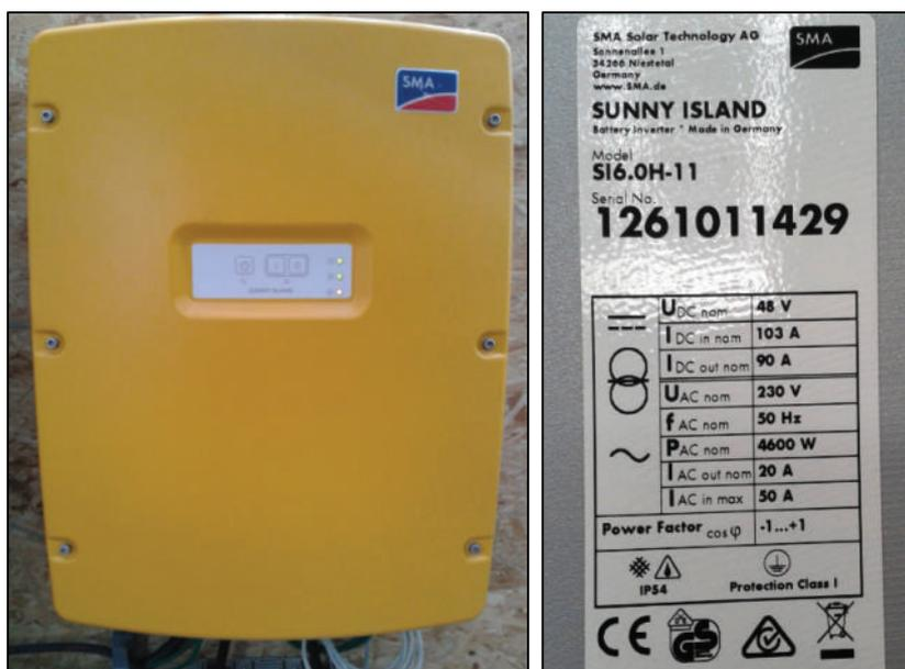
Abbildung 3-36: Sunny Island Steuerungsmodul
