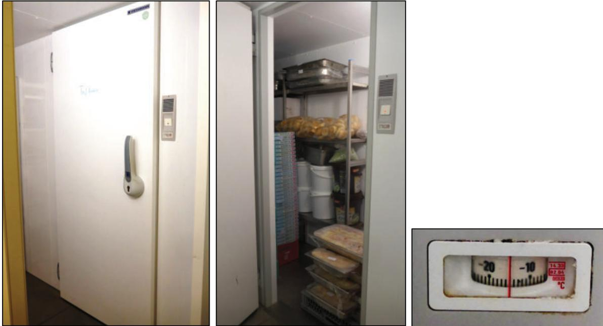
Abbildung 7-51: Tiefkühlzelle – Tür, Einblick, Temperaturanzeige
