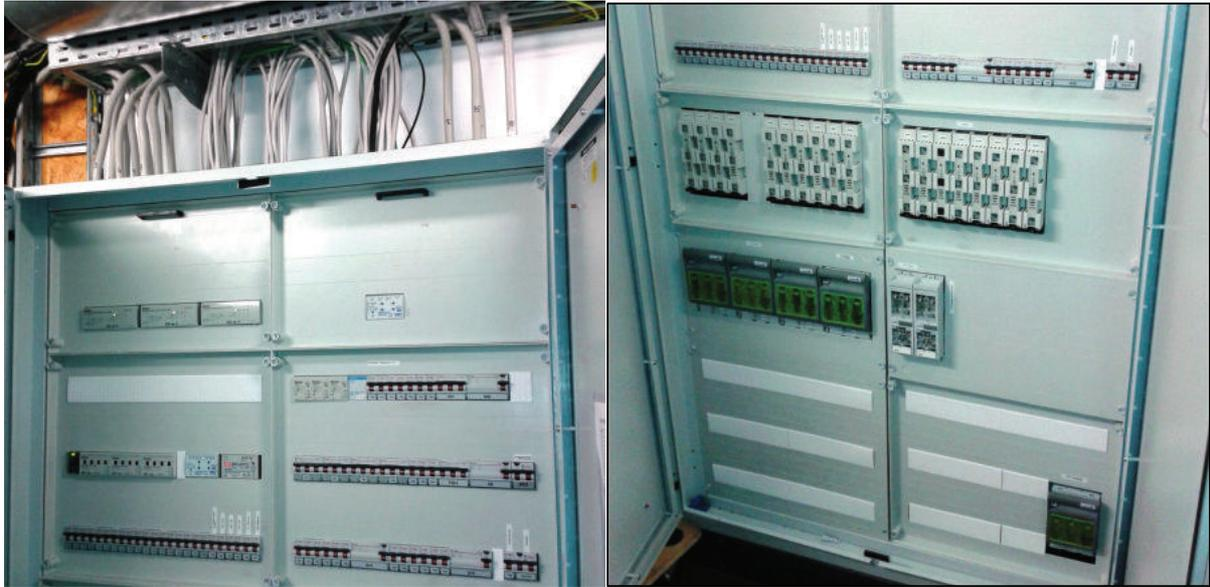
**Abbildung 3-13: Elektroverteilung – Sicherungen der Hauptverteilung**
