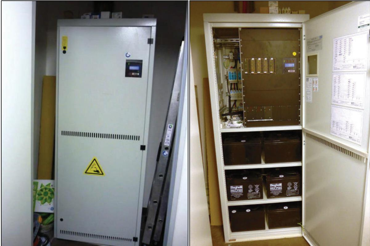
Abbildung 3-9: Blick in den Elektroanschlussraum 0.04 sowie USV in Raum 0.04a
