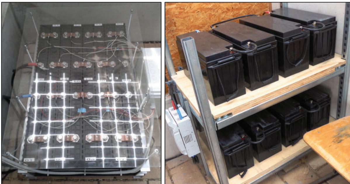
Abbildung 1-4: Komplettbatterie Lithium (links) und Bleigel (rechts)
