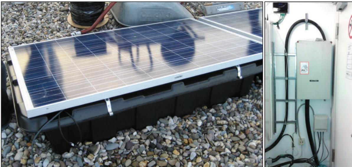
**Abbildung 3-20: PV-Modul mit Unterkonstruktion sowie PV-Hauptanschluss in Raum 0.04**
