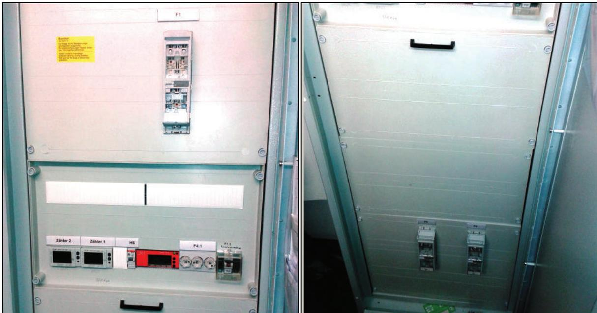
**Abbildung 3-12: Elektroverteilung – Batteriesteuerung und Zählung Carport**
