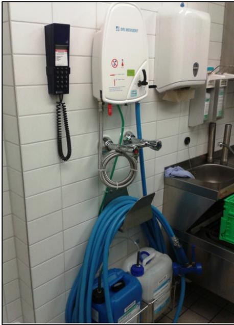
**Abbildung 3-16: Armatur zur Bodendesinfektion in der Küche**
