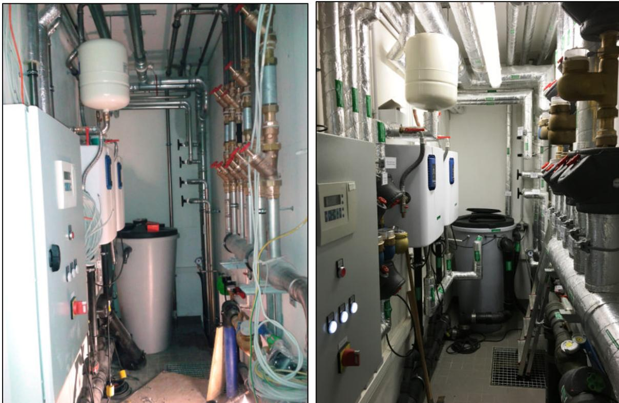
**Abbildung 1-3: Hausanschlussraum 0.18 – Installationsphase und Endzustand**
