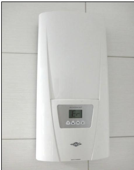
**Abbildung 6-10: Durchlauferhitzer 21 kW**
