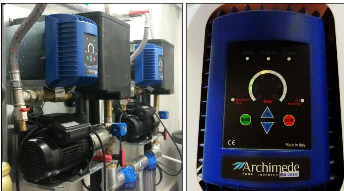
Abbildung 4-15: Doppelpumpe sowie Display mit Regelungseinstellung
