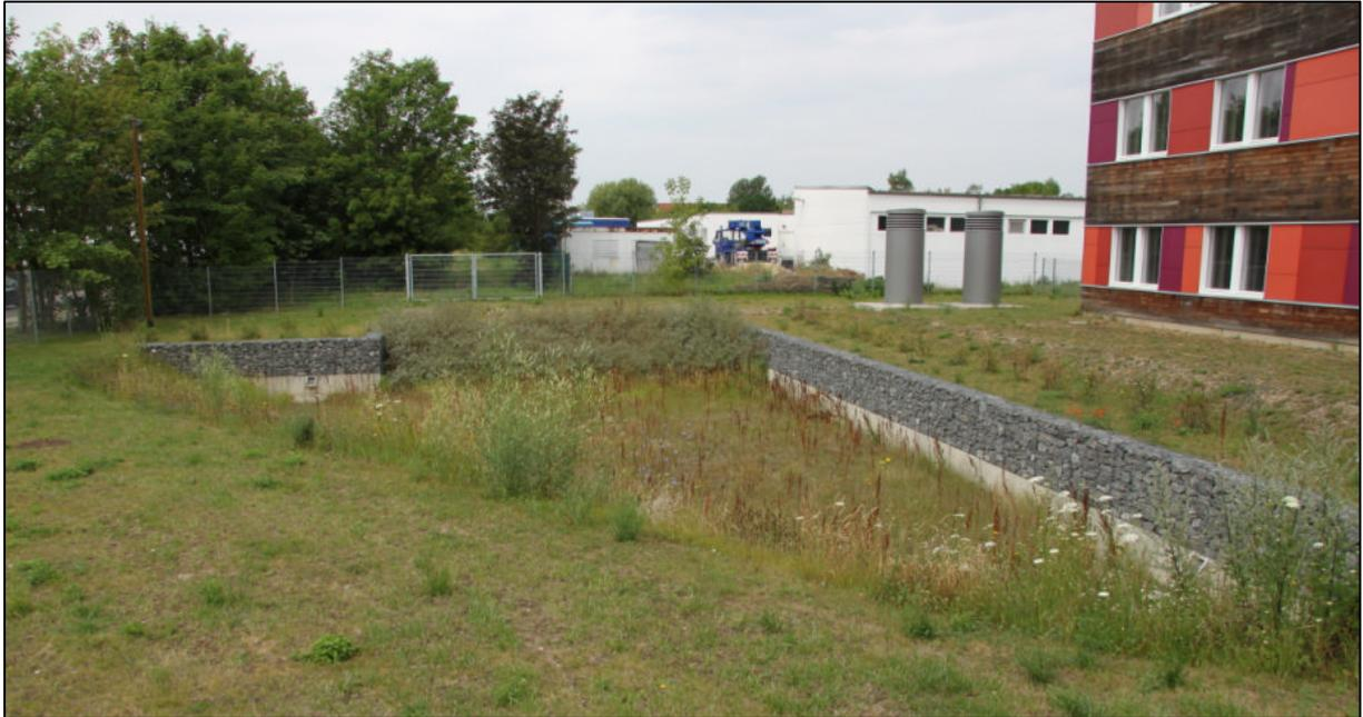
**Abbildung 4-11: Überlauf- und Versickerungsbecken 2017**
