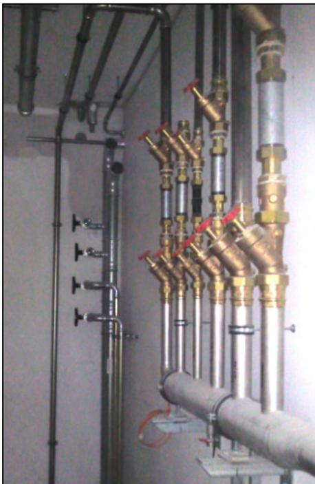
**Abbildung 3-21: Trinkwasserinstallation aus Edelstahl mit Messingarmaturen**
