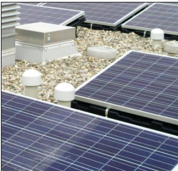
Abbildung 5-20: Lüftungsleitungen über Dach
