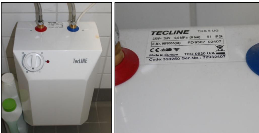
Abbildung 6-4: Kleinspeicher 2 kW mit Typenschild (Raum 0.06)
