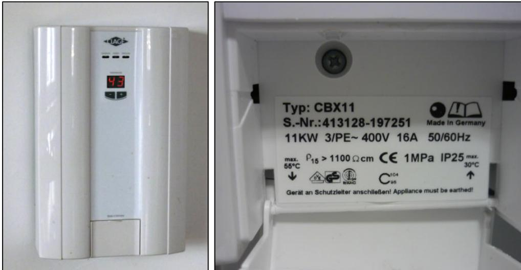
Abbildung 6-2: Durchlauferhitzer 11 kW mit Typenschild (Raum 1.11)
