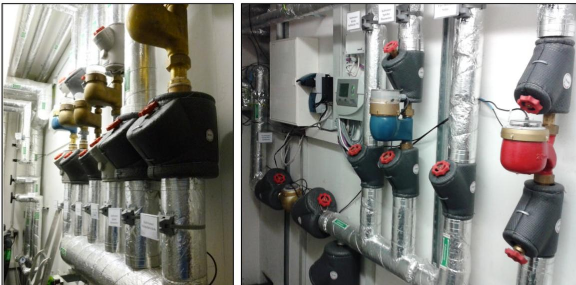
Abbildung 3-19: Unterzähler für Trinkwasser in Raum 0.18 und 0.33b
