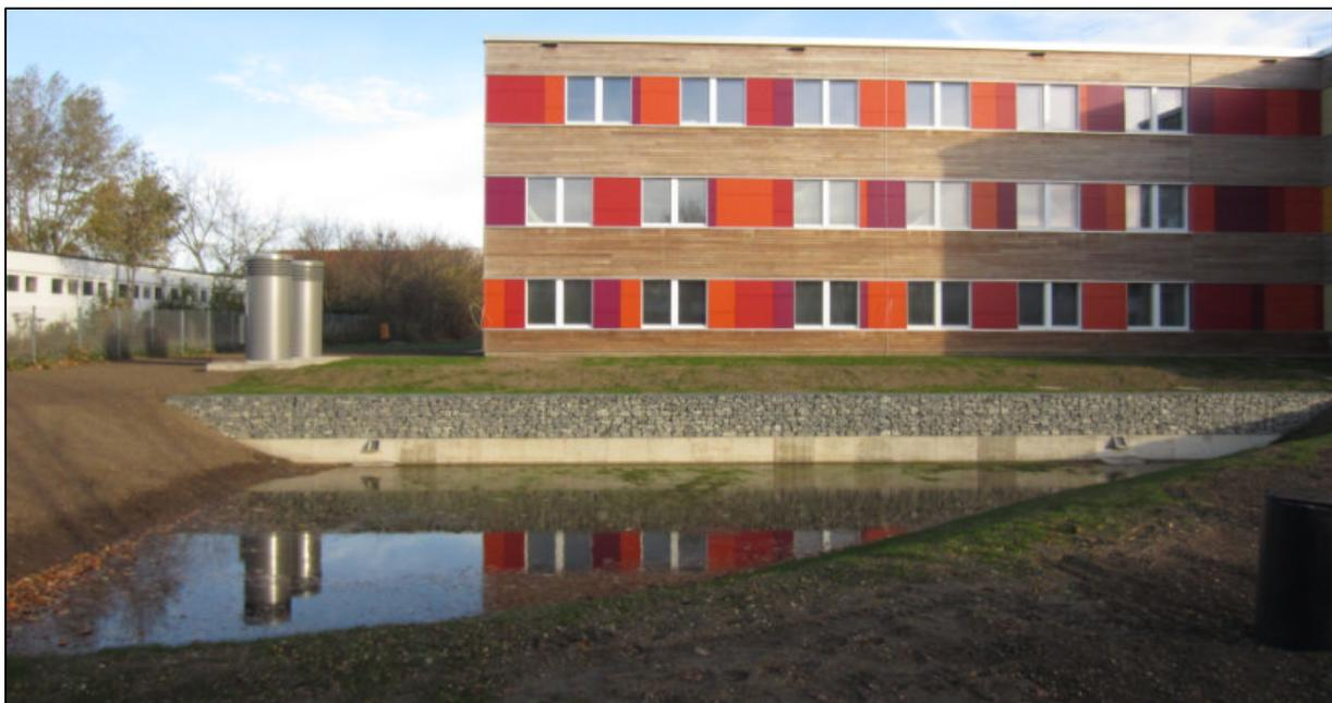
Abbildung 4-10: Überlauf- und Versickerungsbecken 2013
