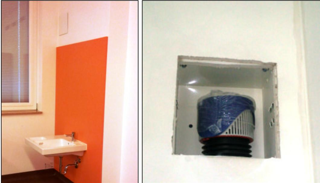
**Abbildung 5-21: Belüftungsventile im 2. OG**
