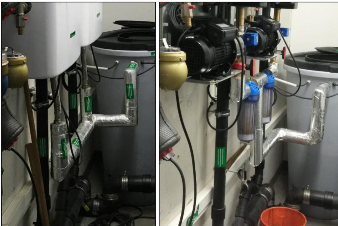
**Abbildung 10-37: Regenwassernutzung vor und nach Filtereinbau**
