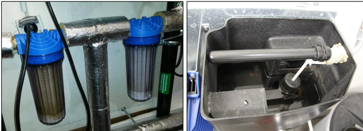
**Abbildung 4-17: Filteranlage und Einblick in die Frischwassernachspeisung**
