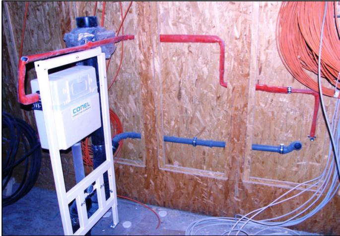
**Abbildung 3-22: Dämmung der Verbundrohr-Stichleitungen mit PE-Isolierschlauch**
