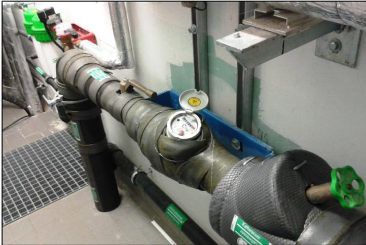
Abbildung 3-18: Hauptwasserzähler in Raum 0.18
