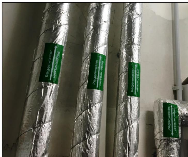
Abbildung 4-20: Regenwassernetz aus Edelstahl mit alukaschierter Mineralwollendämmung
