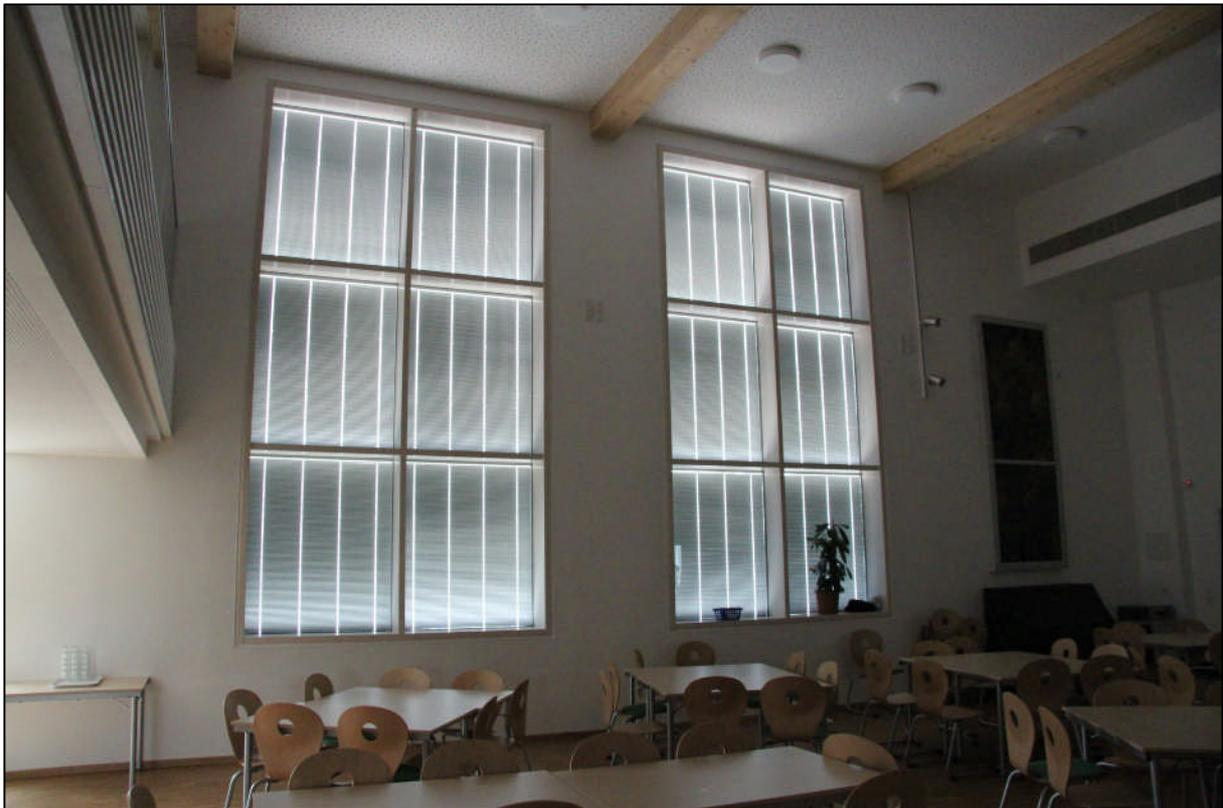
**Abbildung II-82: Pfosten-Riegel-Fassade Aula von innen bei geschlossenem Sonnenschutz**
