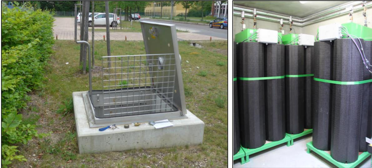
**Abbildung II-60: Eingangsluke zum unterirdischen Speicherraum, Speicherzellen**
