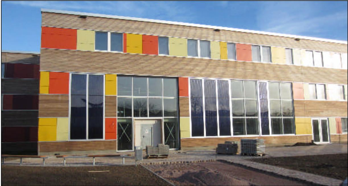
**Abbildung II-58: Ansicht Solarwand mit den 3 Kollektorfeldern (Foto: HS MD)**
