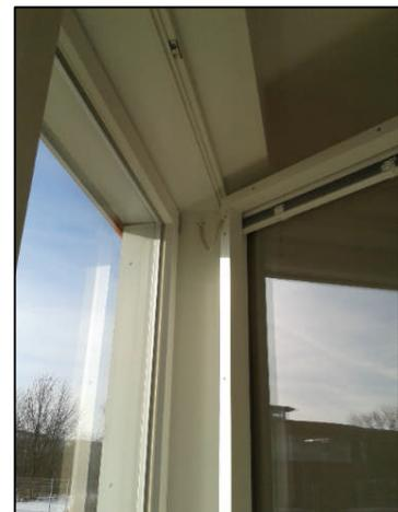
**Abbildung II-21: Blick in den Fensterkasten, hochgefahrenere Jalousie rechts am Innenflügel**
