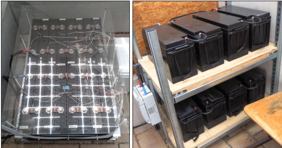
**Abbildung II-69: Komplettbatterie Lithium (links) und Bleigel (rechts)**
