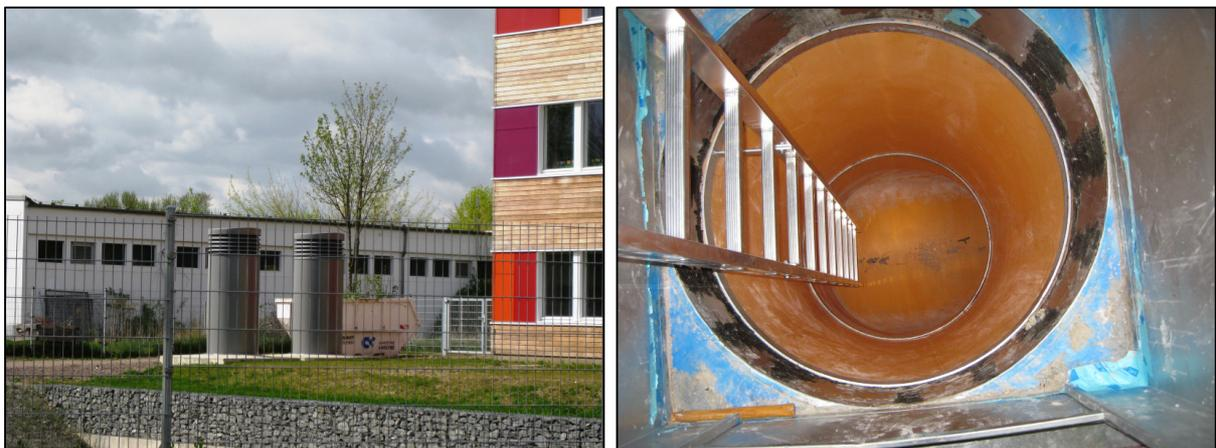
**Abbildung 3-35: Links: Ansaugstutzen der beiden EWT; Rechts: Hauptrohr EWT**
