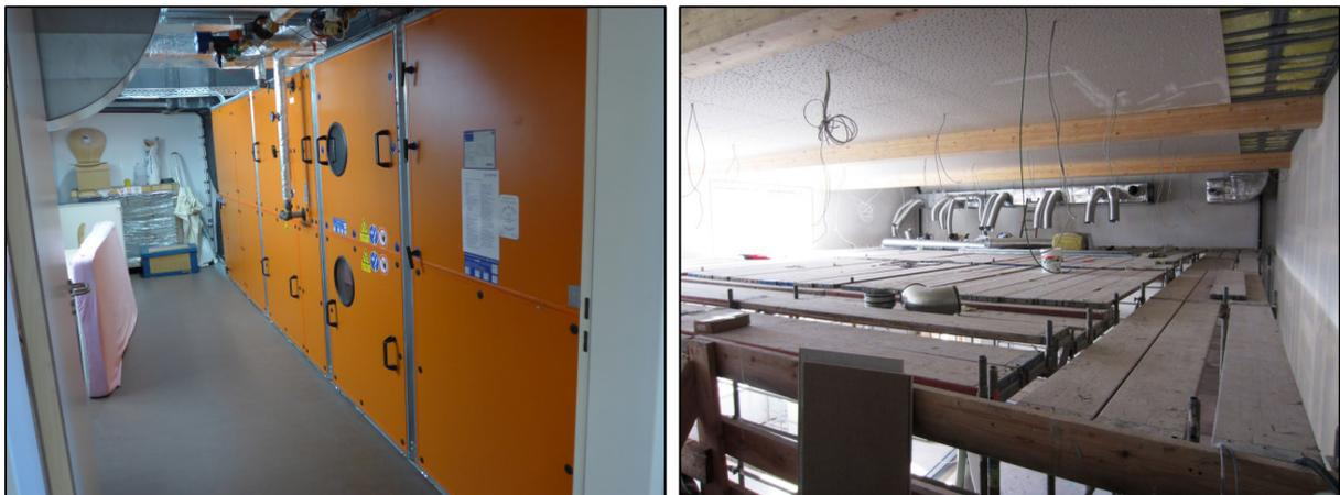
**Abbildung 3-34: Links: Lüftungszentrale R. 2.03, Rechts: RLT der Aula im Bauzustand**
