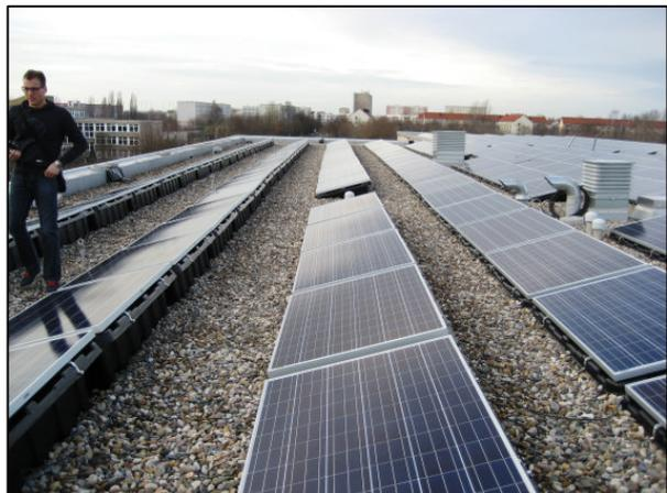
Abbildung 3-32: Links: das fertig abgedichtete Dach; Rechts: bekiest und mit Photovoltaik
