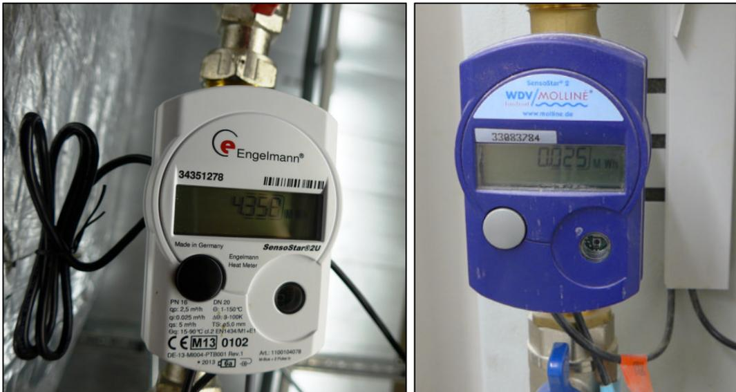
Abbildung 4-12: Wärmemengenzähler ohne Schnittstelle
