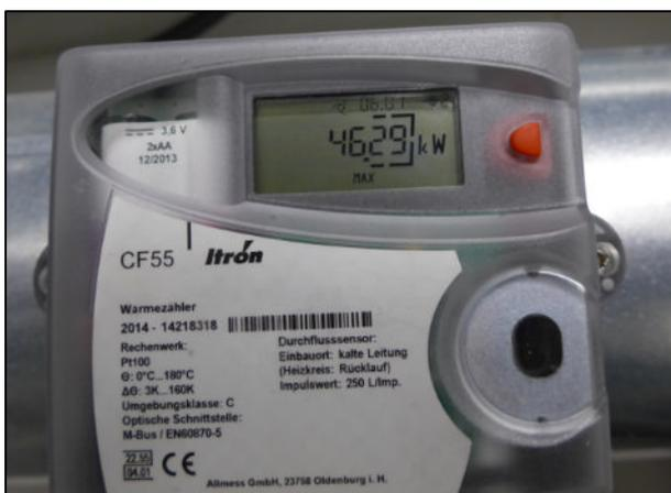
**Abbildung 4-11: Wärmemengenzähler mit digitaler Schnittstelle**
