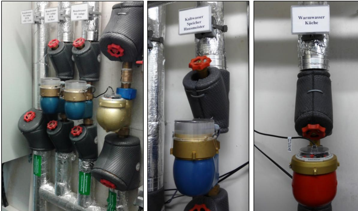
**Abbildung 4-6: Brauchwasser-, Kaltwasser- und Warmwasserzähler**
