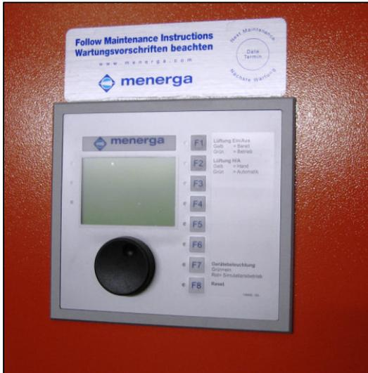
Abbildung 4-16: Regel- und Datenerfassungseinheit von MENERGA
