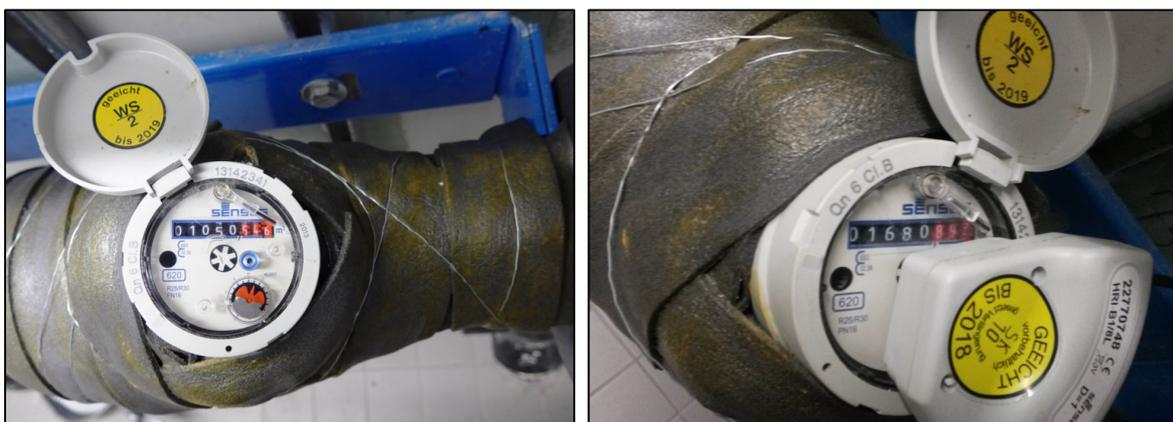
Abbildung 4-5: Wasserzähler der Stadtwerke ohne und mit Reed-Kontakt
