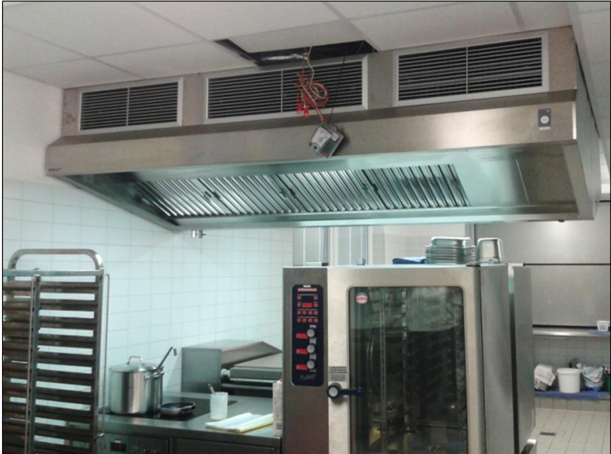
**Abbildung 4-10: Wärmemengenzähler in der abgehängten Decke der Küche**
