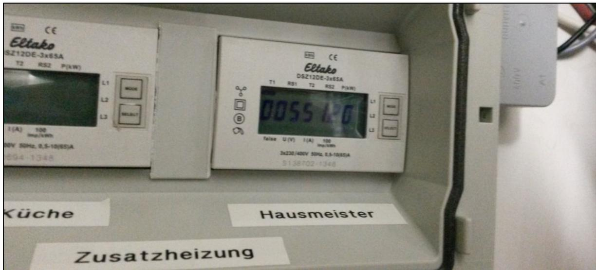
Abbildung 4-4: Digitale Zwischenzähler für Strom
