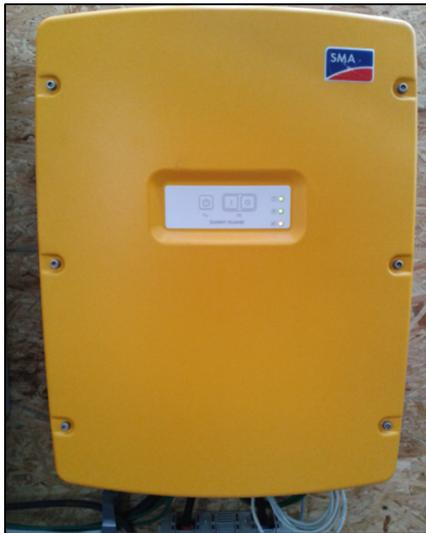
**Abbildung 4-14: Regel- und Datenerfassungseinheit von SMA**
