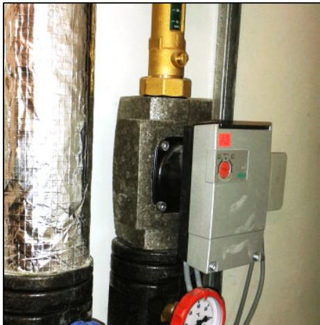
**Abbildung 3-23: Ladepumpe Solarverteiler zum Pufferspeicher (Foto: HS MD)**
