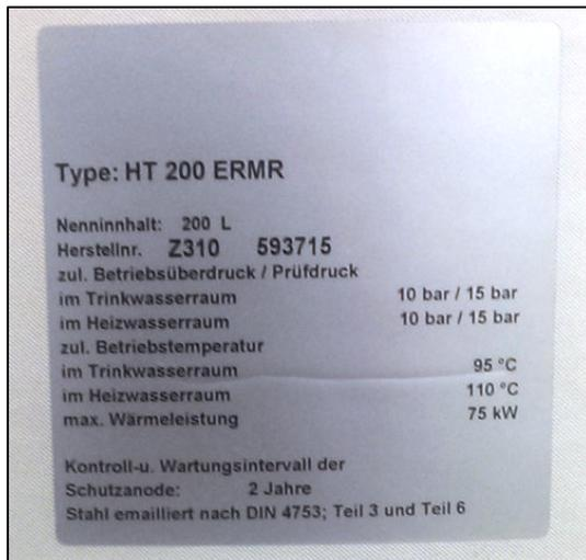
**Abbildung 3-13: Typenschild Trinkwarmwasserspeicher (Foto: HS MD)**
