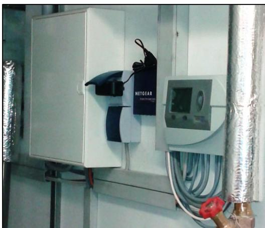
Abbildung 3-28: Zentrale Regelung und Netzwerkanschluss SETSOLAR (Foto: HS MD)
