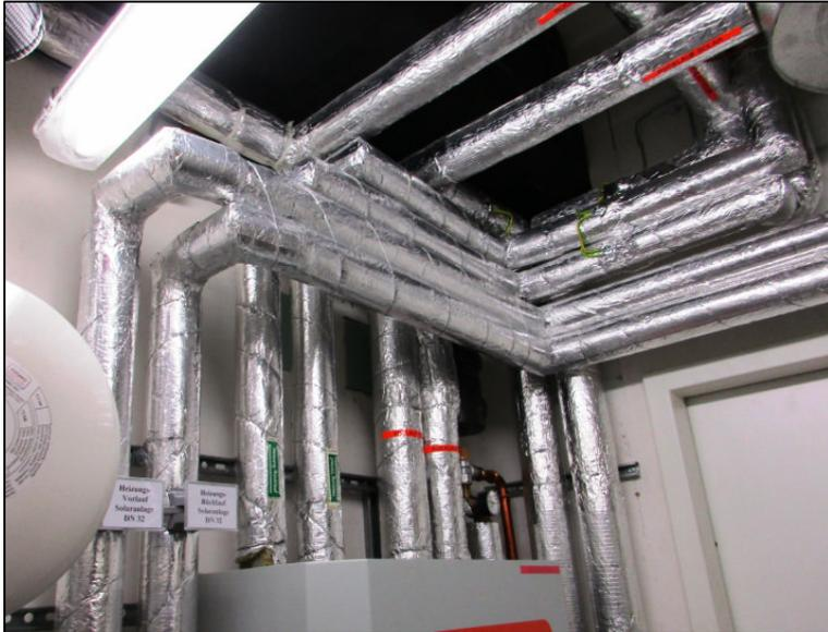
Abbildung 3-16: Dämmung mit alukaschierter Mineralwolle (Foto: HS MD)
