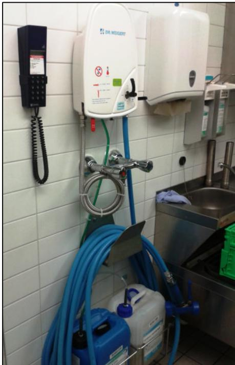
**Abbildung 5-2: Bodenreinigungsanschluss Küche (Foto: HS MD)**
