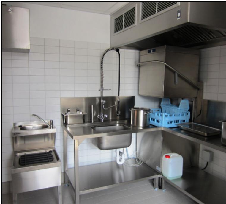
**Abbildung 5-1: Spülmaschine Hobart AMX-16 (Foto: HS MD)**
