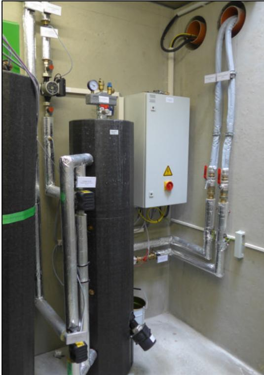
**Abbildung 7-5: Hydraulische Weiche, Regelmodul und Erdleitung**
