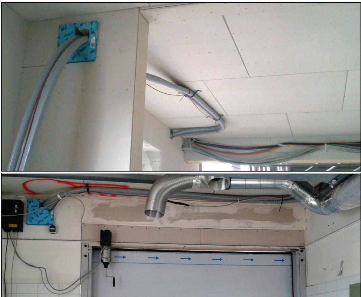
**Abbildung 3-15: Kollektorkreis Gebäudeeinführung und Querung der Küche**
