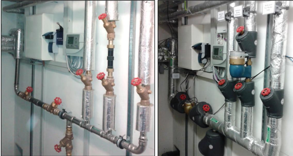
Abbildung 3-21: Armaturen während der Ausführung und danach (Foto: HS MD)
