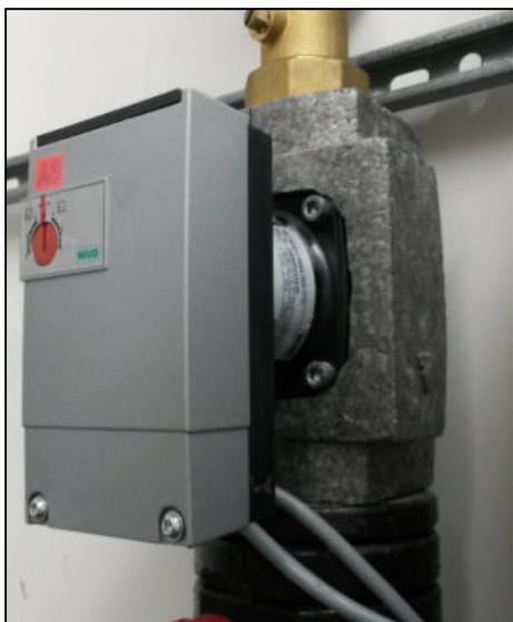
**Abbildung 3-25: Ladepumpe Solarverteiler zum Hausmeisterspeicher (Foto: HS MD)**
