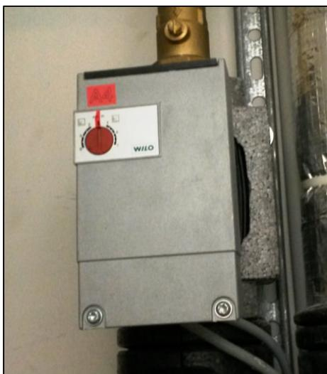
**Abbildung 3-24: Ladepumpe Solarverteiler zum Salzhydratspeicher (Foto: HS MD)**
