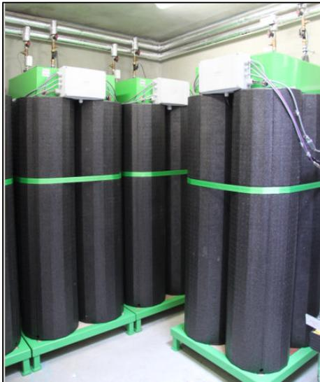
**Abbildung 7-3: Vier Speicherzellen mit je 4 Zylindern**
