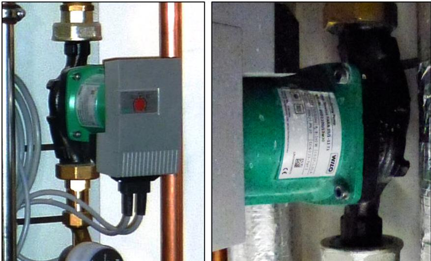
Abbildung 3-22: Kollektorkreispumpe bis zum Solarverteiler (Foto: HS MD)
