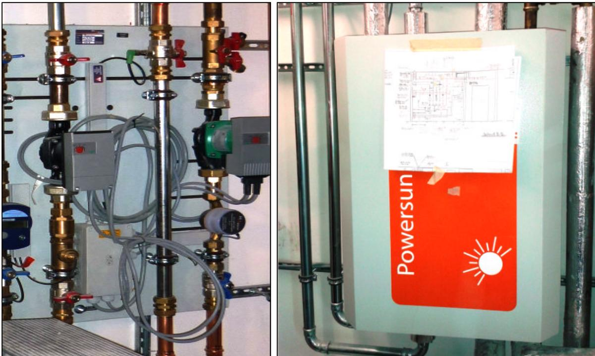
**Abbildung 3-8: Kompaktstation zur Fernwärmenachladung geöffnet (Foto: HS MD)**
