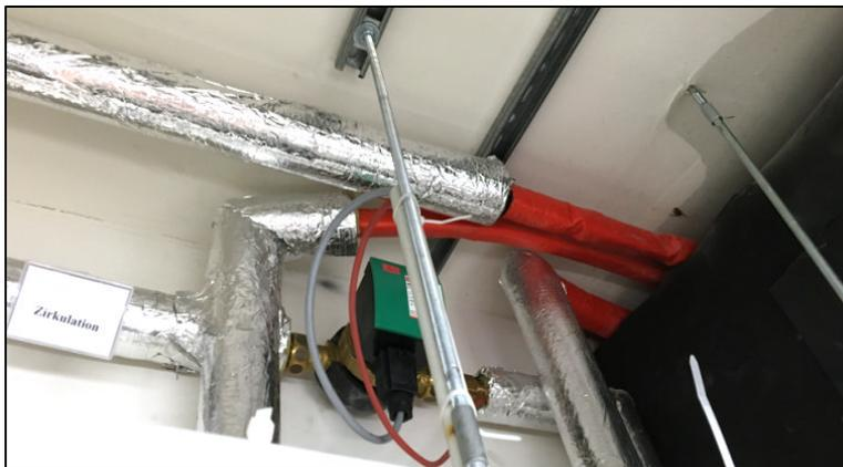
**Abbildung 3-20: Nicht ausreichende Dämmung (Foto: HS MD)**
