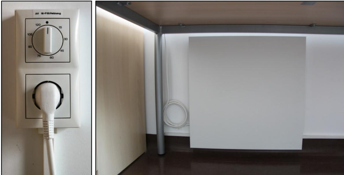
**Abbildung 3-33: Nachgerüsteter Elektroheizkörper mit Zeitschaltuhr im Raum 2.16**
