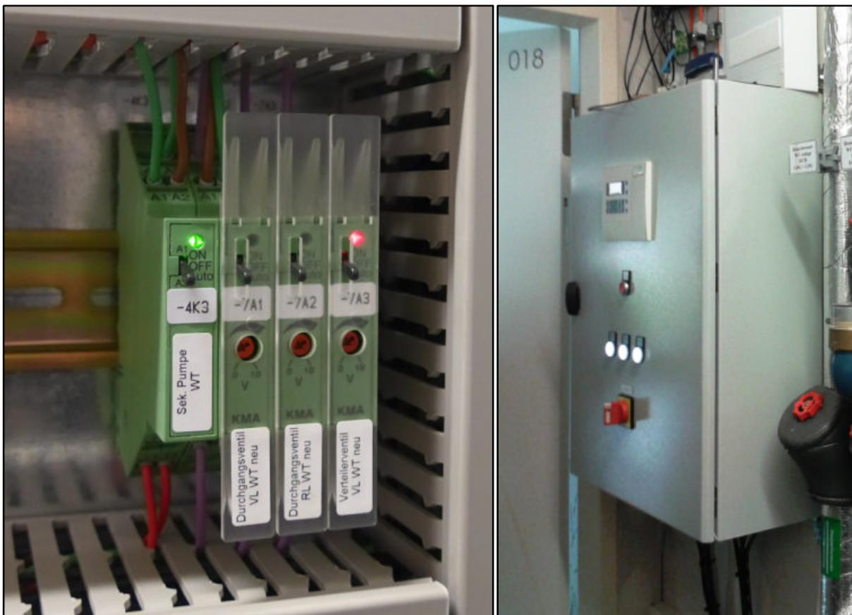
Abbildung 7-10: Möglichkeit zur Handumschaltung der Ventile im Schaltkasten
