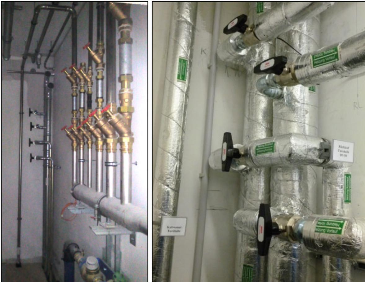
Abbildung 3-41: Heizungsleitungen (hintere Wand) vor und nach der Dämmung
