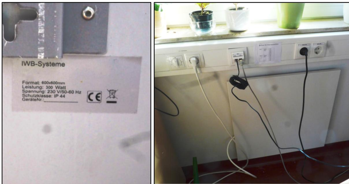
**Abbildung 3-32: Elektroheizkörper und Typenschild im Raum 2.16**
