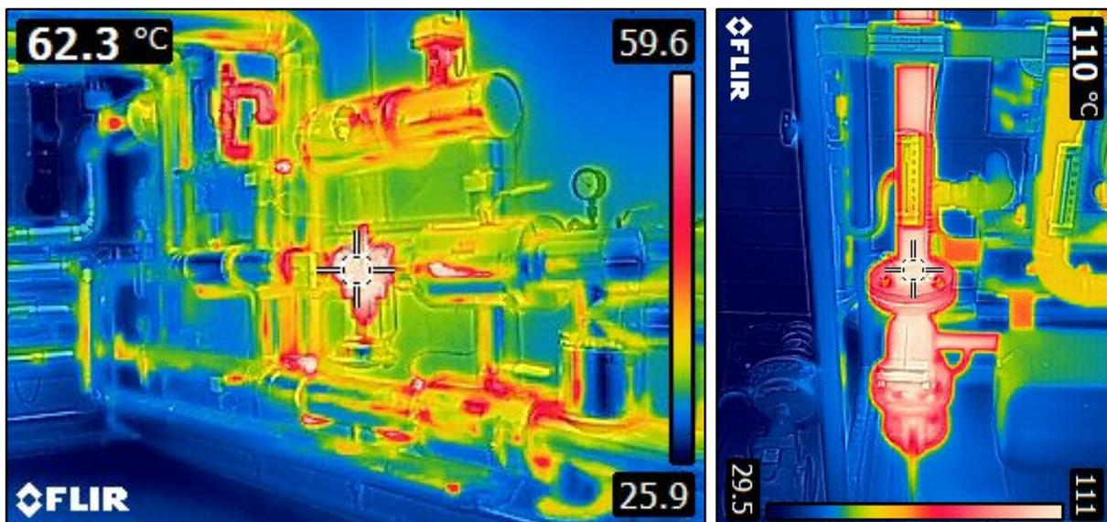
Abbildung 3-12: Temperaturen an ungedämmten Leitungsteilen (Januar 2016)
