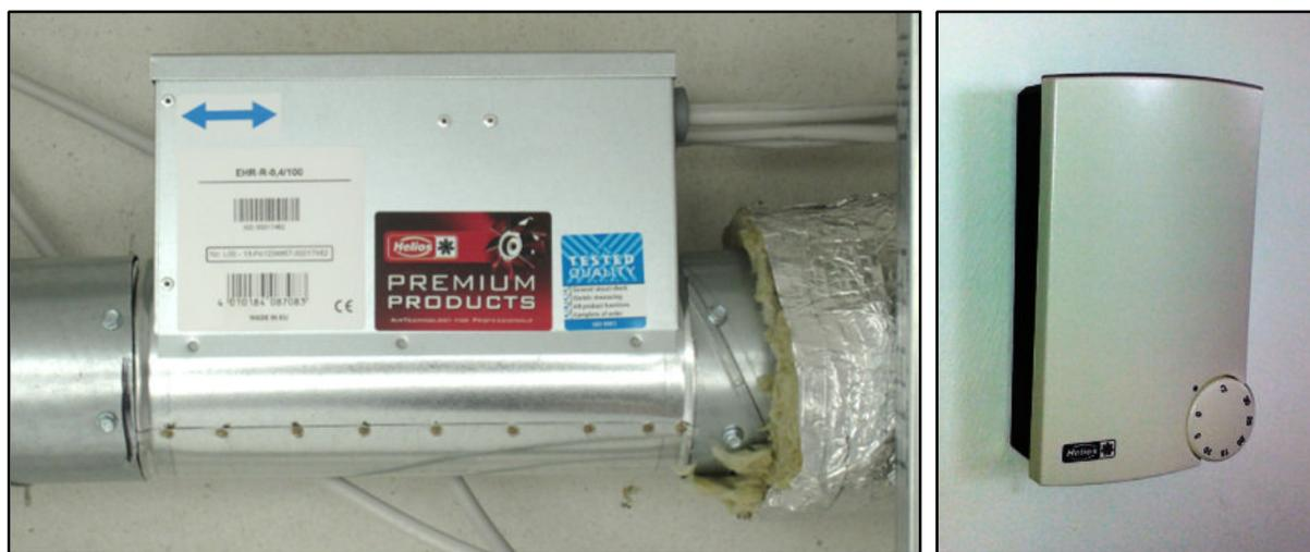
Abbildung 3-31: Nachheizregister 0,4 kW im Luftkanal mit Einzelraumregelung
