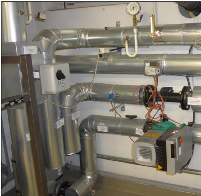
**Abbildung 3-20: Umschaltventil M3**
