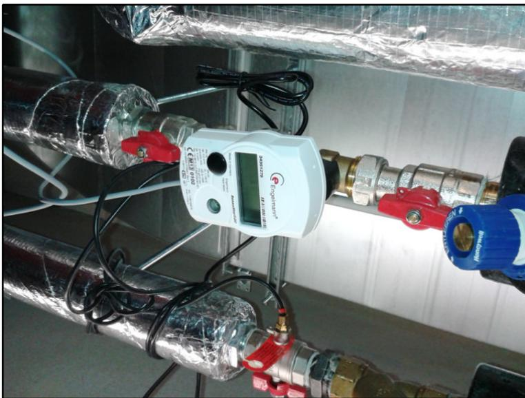
Abbildung 3-38: Unterzähler Nachheizregister Flure in Raum 2.18
