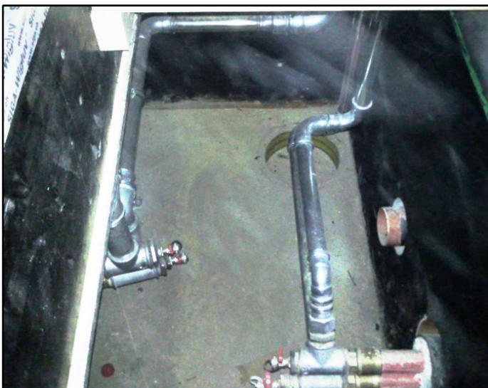
Abbildung 3-14: Anschlusschacht mit Heizungsleitungen während der Installation
