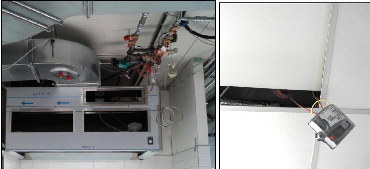
Abbildung 3-40: Wärmemengenzähler Spülhaube über Spüle in Raum 0.33a
