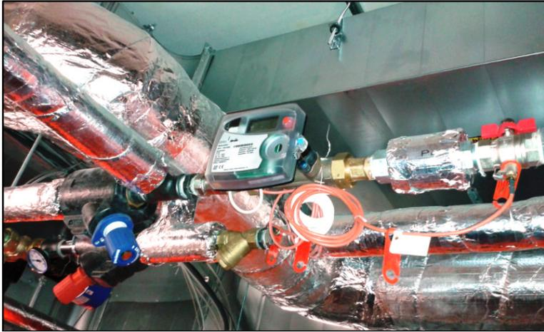
Abbildung 3-37: Wärmemengenzähler Verwaltungstrakt in Raum 2.18
