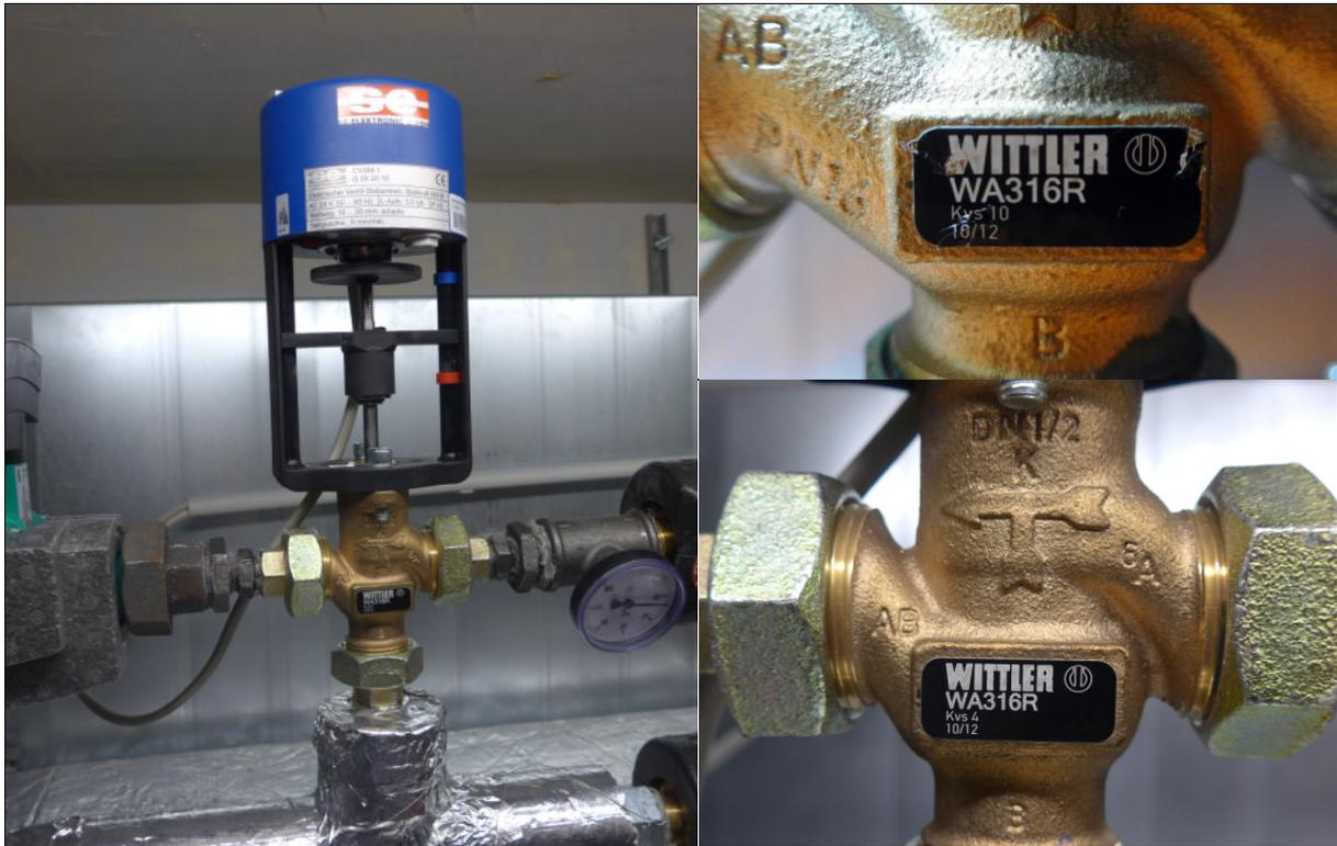
**Abbildung 3-21: Regelventile an den Heizregistern der Lüftungsanlagen**
