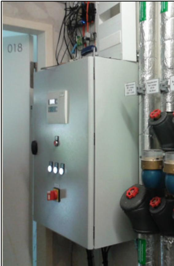
**Abbildung 3-15: Schaltkasten für Heizungsregelung**
