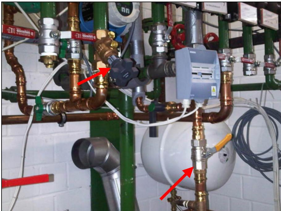
**Abbildung 13: Drosselventil und Motorventil im Kühlwasserkreis**
