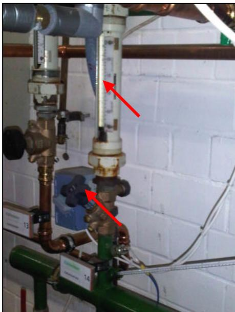
**Abbildung 12: Drosselventil und Motorventil im Kühlwasserkreis**
