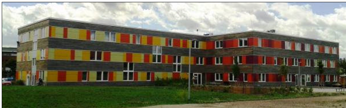
Bild 1 Nordansicht der St. Franziskus-Grundschule
