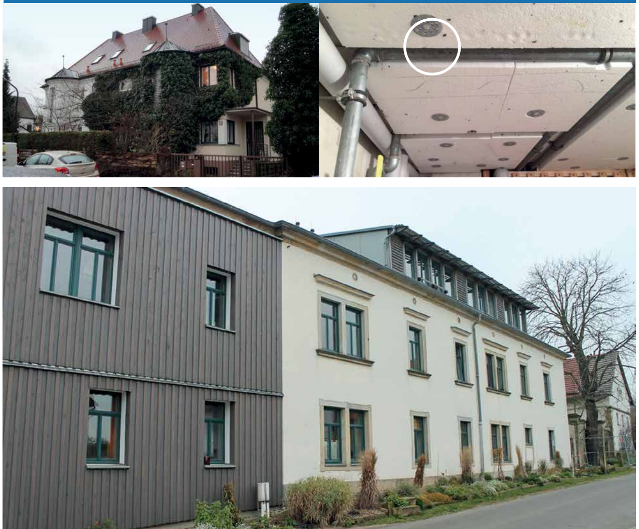
Abb. 18 Sanierungstest: Dachdämmung am Gebäude mit Baujahr 1936 (o. l.), Probleme bei der Dämmung der Kellerdecke (o. r.), Gebäude mit teilweiser Fassadendämmung (u.)
