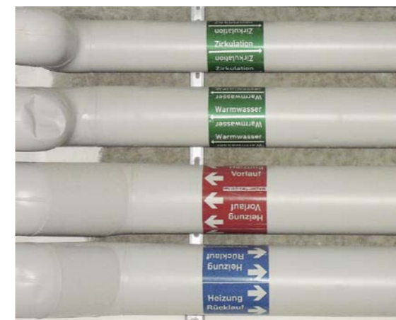
6 Bei der Zirkulation gilt es laut Studie ein Optimierungspotenzial von mindestens 5 kWh/(m 2 a) zu heben. Im Bild ein Vierleiternetz.
