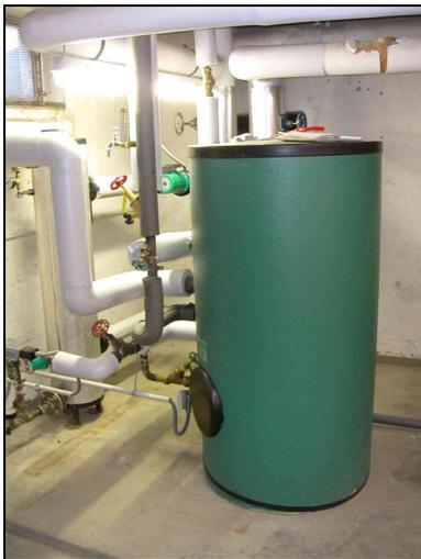
**Bild 13 Übergabestation mit Trinkwarmwasserspeicher**
