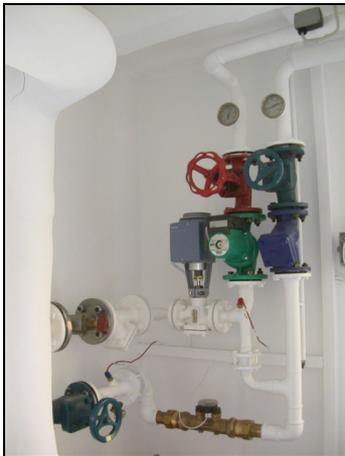
**Bild 11 Übergabestation ohne Trinkwarmwasserbereitung**
