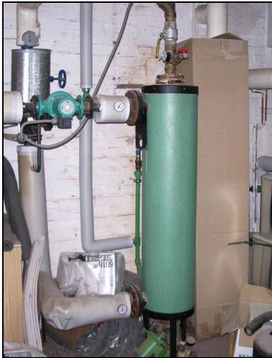
Bild 15 Übergabestation mit Durchlaufwassererwärmer
