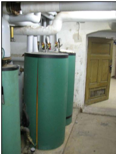
**Bild 17** Übergabestation mit Durchlaufwassererwärmer und Speicher
