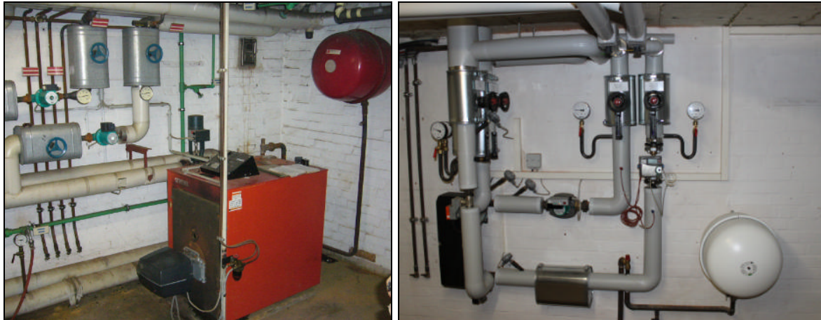
Abbildung 2 Kessel wird ersetzt durch Übergabestation
