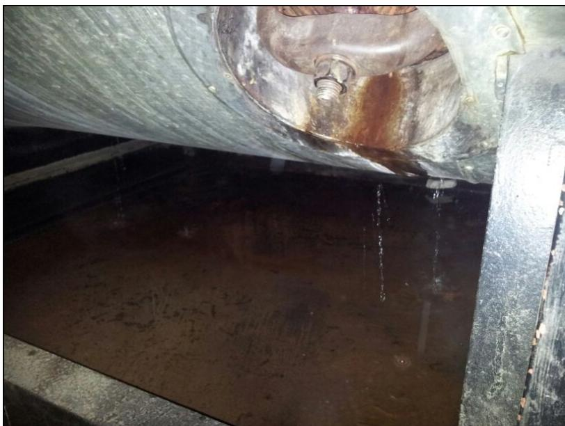
**Bild 11 Undichtigkeiten Dampfkessel 2 bei Dampfdruck  $p_e = 0,5$  bar**
