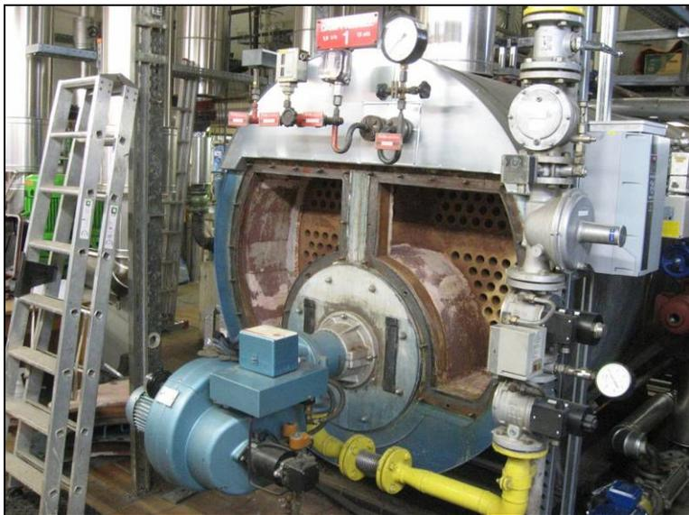
**Bild 1 Dampfkessel im offenen Zustand während Wartungsarbeiten**
