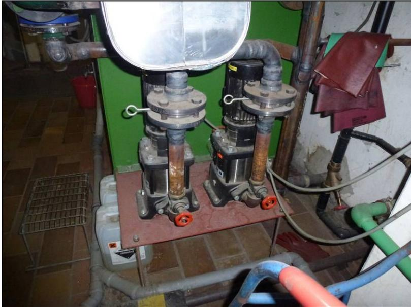
**Bild 4 Kondensatpumpen**
