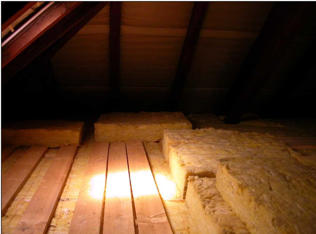
*Bild 4 Dämmung der obersten Geschossdecke*
