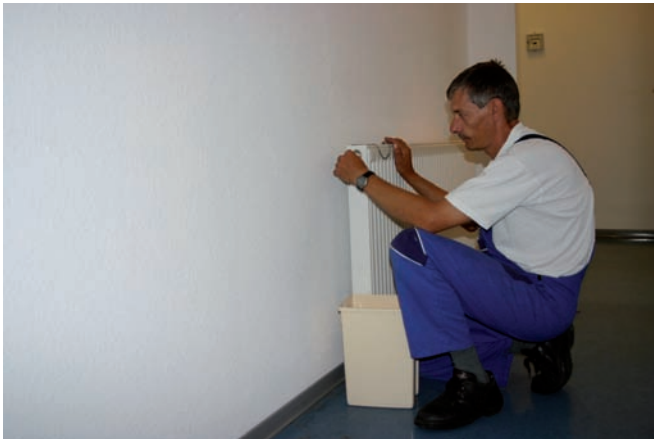
Foto: Ein Heizkörper wird entlüftet
