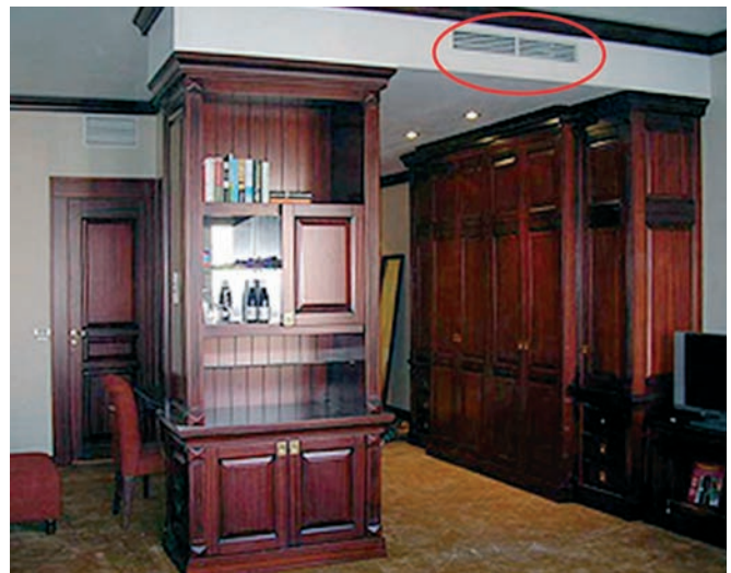
Beispiel für die Zimmer-Klimatisierung mit VRF-Multisplitanlagen in einem 5-Sterne-Hotel
