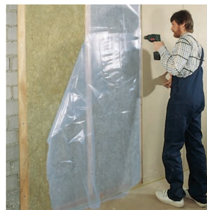
Ausführung der Innendämmung mit einer matenförmigen Dämmung und Dampfbremse
