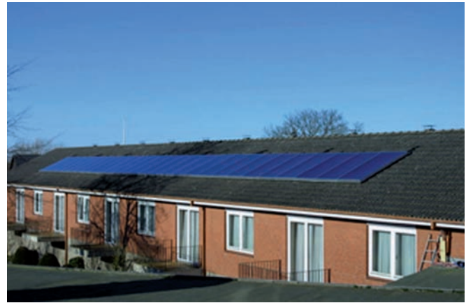
Solarthermische Anlage auf dem Dach des Witt's Gasthof.
