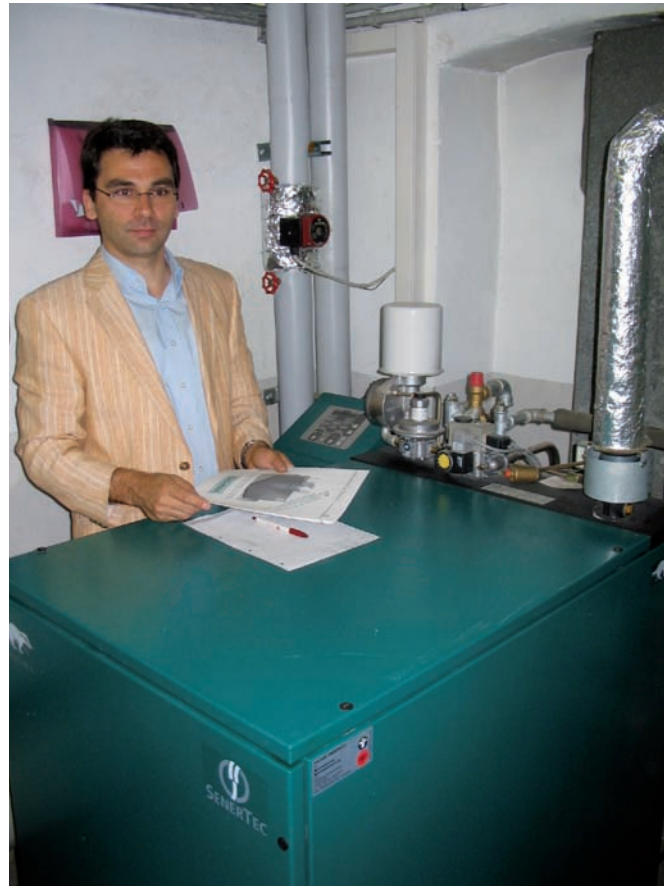
Abbildung: Blockheizkraftwerk im Hotel Kastanienhof.
