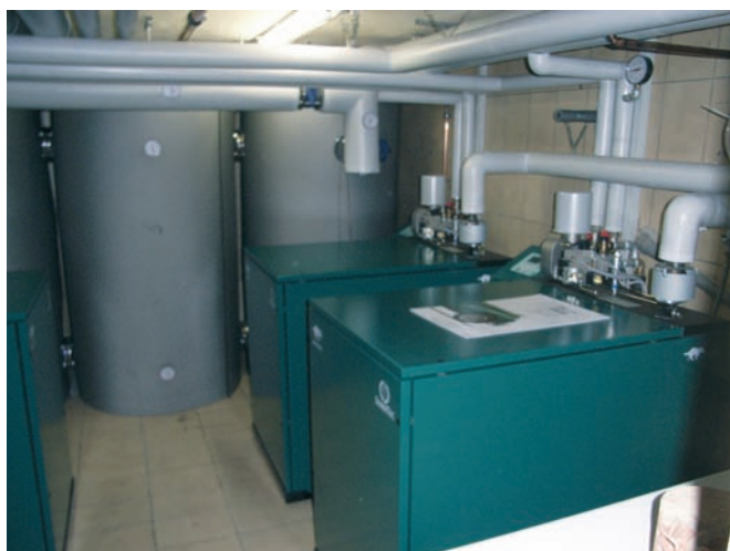
Blockheizkraftwerk aus 3 Modulen mit Pufferspeichern
