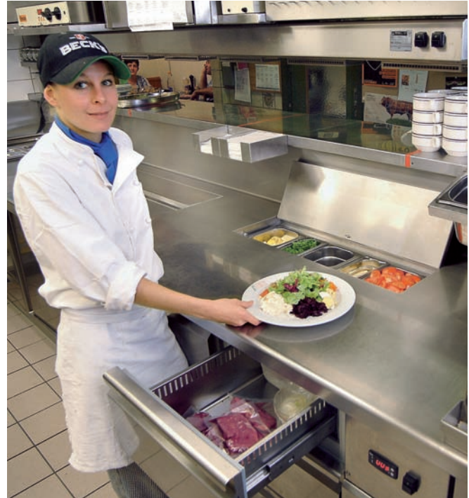
Die Kälte in den Kühltubladen wird gleichzeitig für die Kühlung von Garnituren und Salaten genutzt.
