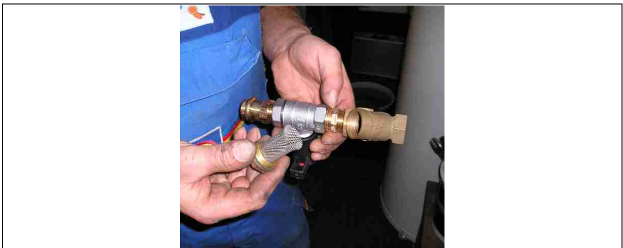
Abbildung 11 (N17) Filterunterteil und Filterelement vor dem Einbau
