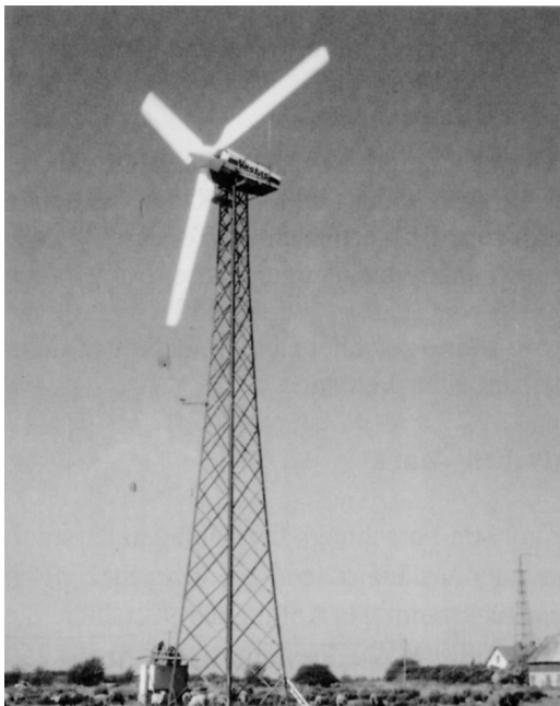
Abb.1.4.3: Dänische Windkraftanlage VESTAS V15-55 (Gasch; 1996, S. 45)
