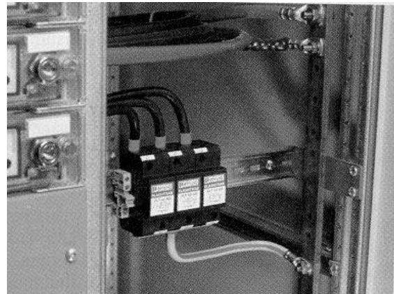
Abb.7.1.3: Zone 1 des EMV-Schutzzonenkonzepts; c t 17/1999, S.141
