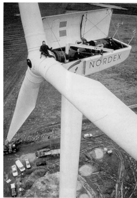
Abb. 1.4.6: Europäische Anlage der Megawatt-Klasse NORDEX N 52 (Gasch; 1996, S. 42)
