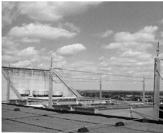
Abb.7.1.2: Zone 0 des EMV-Schutzzonenkonzepts; c t 17/1999, S.141
