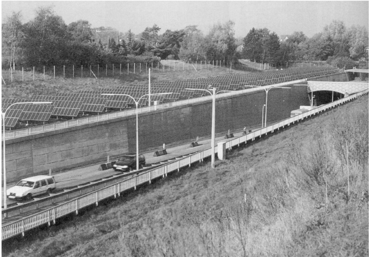
Abb.1.7.2: Photovoltaikanlage zur Beleuchtung eines Staßentunnels (Schmid –Photovoltaik; 1994,S.200)
