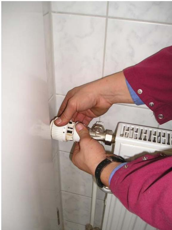
Der Thermostatkopf des vorhandenen Ventils wird abgenommen und das Ventil ausgebaut, da es nicht voreinstellbar ist
