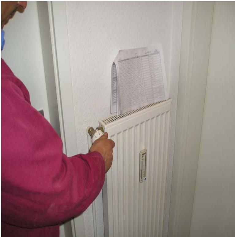
Nach der Voreinstellung wird nur noch der Ventilkopf aufgesetzt. Jetzt ist das neue Ventil optimal an die Bedingungen in der Anlage angepasst
