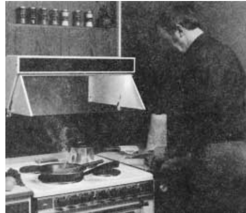
Dunstabzugshaube, richtig angebracht (Fortluft direkt nach Außen)
