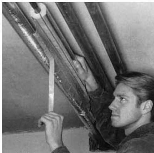
Ungedämmte Rohrteile im Heizungskeller läßt die Heizungsanlagenverordnung nicht zu
