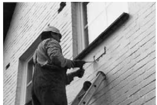
Ein Verblendstein unterhalb der Fensterbrüstung wird entfernt, damit das Granulat eingeblasen werden kann.
