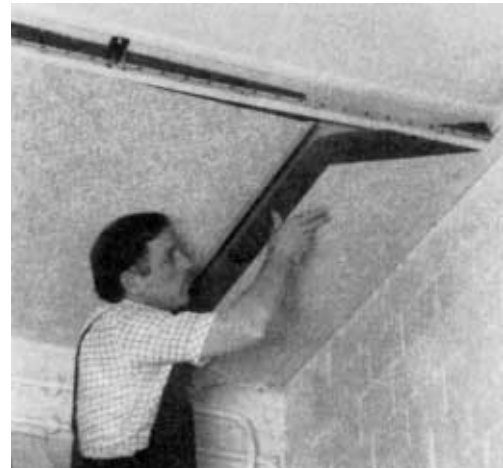
Kellerdeckendämmung
