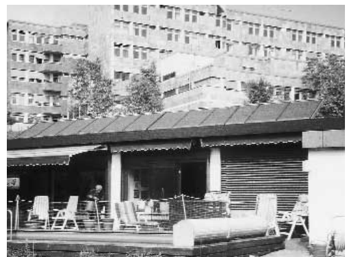
Nachgerüstete Solaranlage auf dem Flachdach eines Bungalows.
