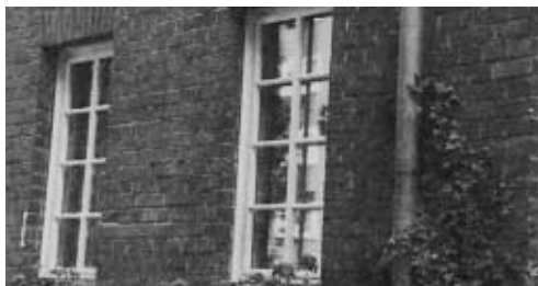
Verbundfenster im Denkmalschutz: Außen Einfachverglasung mit Sprossen, innen durchgehende Isolierglasscheibe
