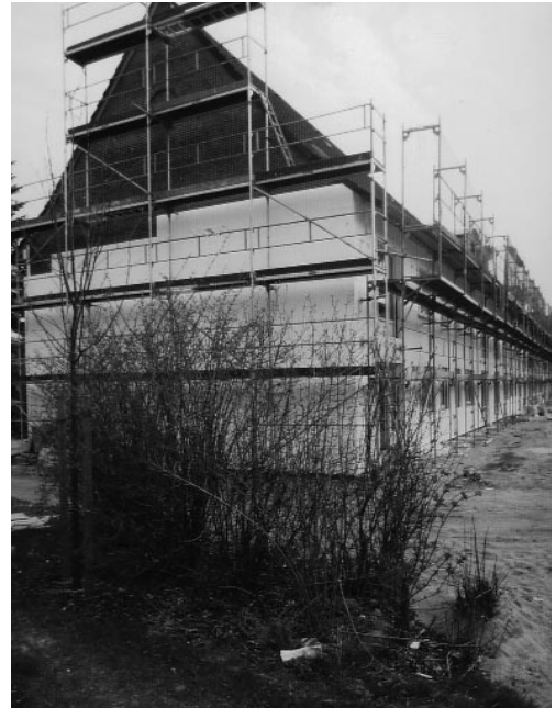
Bei diesen Wohnhäusern in Kiel-Schönkirchen, Anschützsiedlung, wurde von 1993 bis 1997 eine wärmetechnische Sanierung der kompletten Fassade durchgeführt. Ein Wärmedämmverbundsystem mit einer Dämmstoffdicke von 10 cm wurde angebracht.
