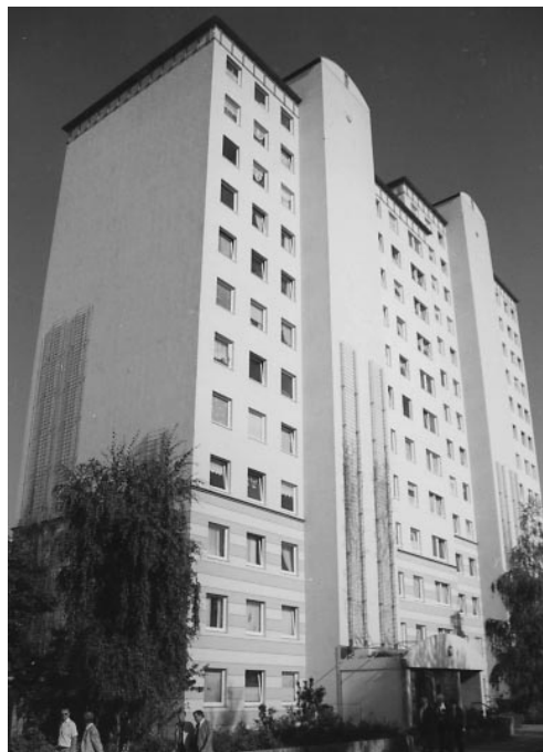
Diese Wohnhäuser in Kiel-Mettenhof, Bergengring, wurden nachträglich mit einem Wärmedämmverbundsystem versehen. In einem sozial problematischen Stadtteil ist neben der Sanierung des Baukörpers und
