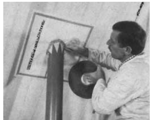
Das Foto zeigt eine Folienringmanschette, die mit doppelseitigem Klebeband auf die Dampfsperre und mit breitem einseitigen Klebeband rings um das Rohr gewickelt wird. Foto: Grünzweig + Hartmann.
