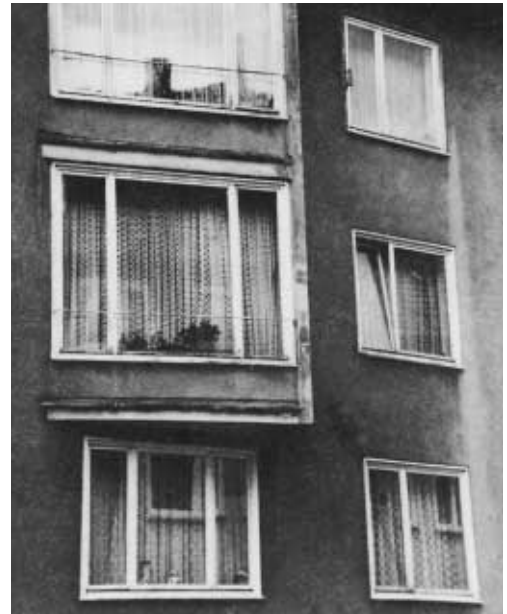
Vermeidbare Energieverluste entstehen Jahr für Jahr durch solche einscheibenverglasten Fenster.
