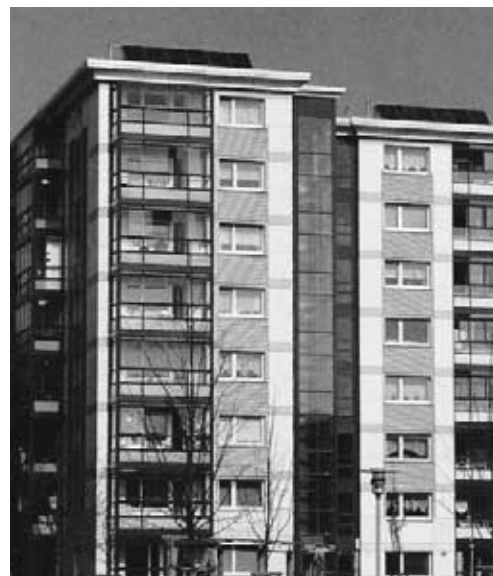
Sanierungsprojekt Flensburg-Engelsby: Zu erkennen ist die aufgeständerte Solaranlage auf dem Dach des Gebäudes.
