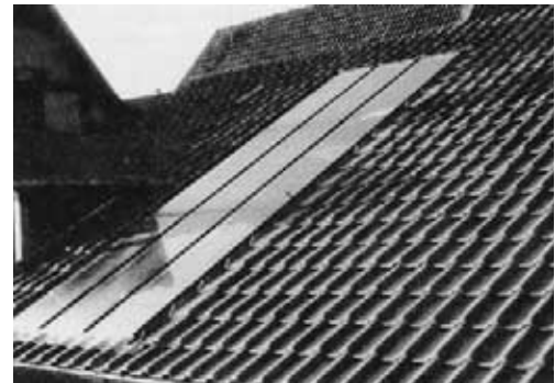
In die Dachdeckung integrierter Flachkollektor
