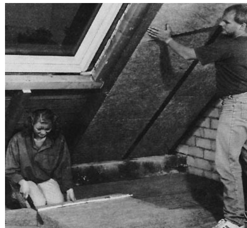
Abb. 7: Bei unkaschierten Dämmstoffen wie diesen Dämmkeilen können Ausführungsfehler korrigiert werden, weil man Fehlstellen beim Einbau sieht.
