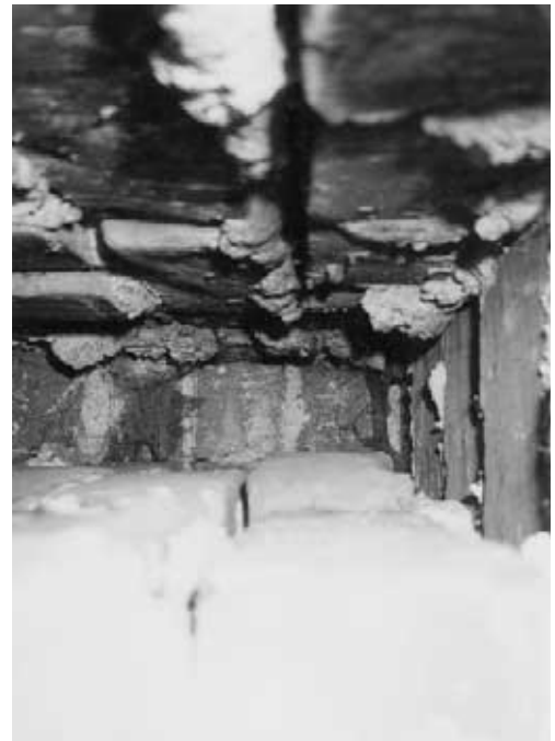
Zweischaliges Ziegelverblend- mauerwerk mit Kern- dämmung
