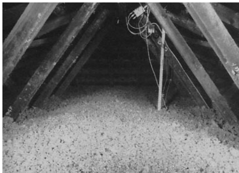
Abb. 6: Von 500 auf rund 50 m 3 Erdgas pro Jahr konnten die Wärmeverluste durch diese Dachdecke (80 m 2 ) reduziert werden. Die 20 cm starke Dämmung war mit dem Einblasverfahren in drei Stunden ausgeführt.
