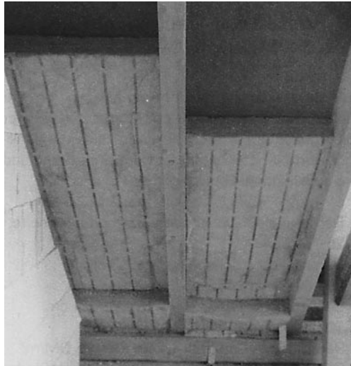
Abb. 22: 20 cm Sparrenhöhe sichern bei diesem Neubau eine Dämmstoffdicke von 20 cm zwischen Sparren (unbelüftet). Zwei cm Dämmplatten werden unter dem Sparren zwischen der Konterlattung angeordnet. Eine Weichfaserplatte als Unterdach statt einer Unterspannbahn bietet einen zusätzlichen Wärmeschutz auf dem Sparren. Der U-Wert beträgt 0,188 \text{ W}/(\text{m}^2\text{K}) .
