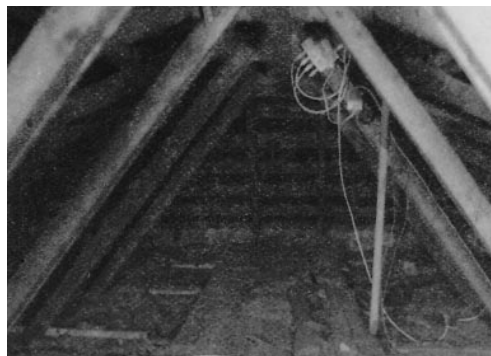
Abb. 1: Bei diesem Dachboden trennt nur der Verputz und eine zusammengefallene Glaswolleplatte (3 cm) die warme Raumluft von der Außenluft. Seit 1955 gehen so Jahr für Jahr 500 m 3 Erdgas verloren.
