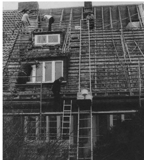
Abb. 23: Bei diesem Gebäude wird die Dachneueindeckung mit einer Verbesserung der Dachdämmung verbunden. Eine Wohnungsbaugenossenschaft senkt durch Kombination von Instandsetzung und Dämmung Schritt für Schritt den Heizenergieverbrauch in ihrem Gebäudebestand.
