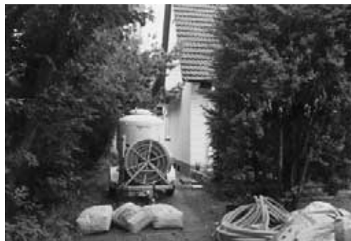
Einblasgerät, Granulatsäcke und Einfüllschläuche auf der Baustelle.
