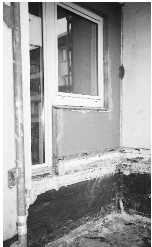
Die Aufnahme zeigt einen abgebrochenen Balkon im Erdgeschoß, der nun eine großzügige Terrasse erhält. Die Fassade wird zusätzlich energetisch saniert.
