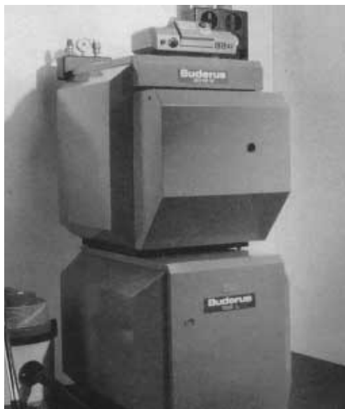
Kessel mit liegend angeordnetem unteren Warmwasserspeicher
