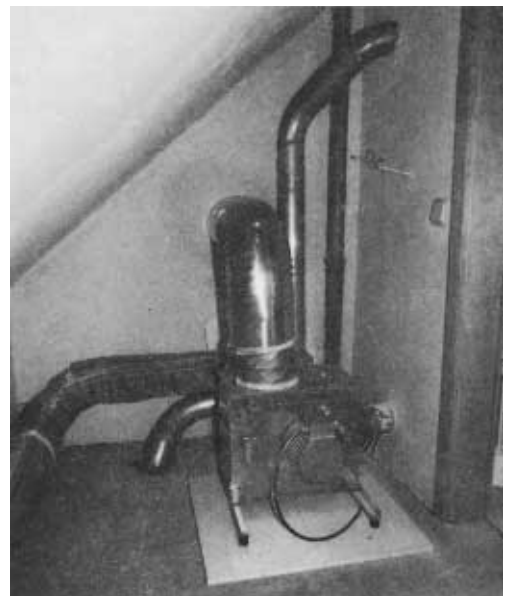
Zentrales Ventilatorgerät mit 50 Watt Antriebsleistung, Abmessungen: Würfel mit ca. 30 cm Kantenlänge.
