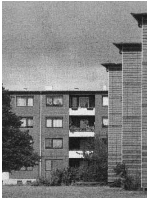
Im Hintergrund: Gebäude vor der Sanierung Rechts im Vordergrund: Gebäude nach der Fassadensanierung mit einer vorgehängten Ziegelfassade
