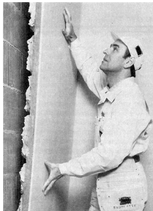
Anbringung einer Gipskarton-Verbundplatte mit Mineralfaserdämmung und Dampfsperre.
