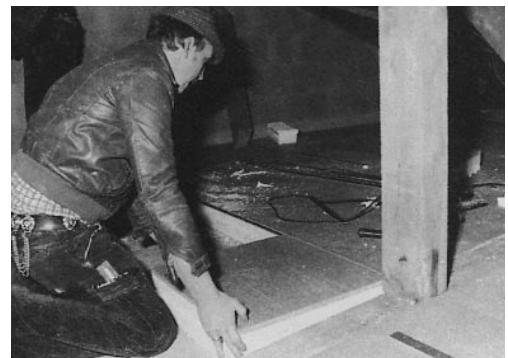
Abb. 5: Hier wird die nackte Betondecke eines Reihenhauses mit 12 cm dicken Verbundplatten gedämmt.
