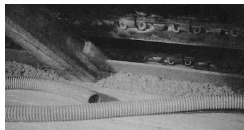
Abb. 8: Hier wurden Zelluloseflocken vom Spitzboden in die Dachschräge geblasen.
