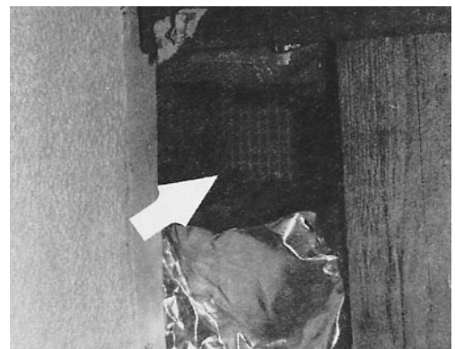
Abb. 2: Durch dieses Loch in der Dämmung zwischen den Sparren blickt man bis auf die Unterspannbahn. Die warme Raumluft kann ungehindert entweichen. Die Folge sind nicht nur Wärmeverluste und unbehagliche Zugluft, sondern auch mögliche Bauschäden durch Tauwasser-ausfall an der Unterspannbahn.
