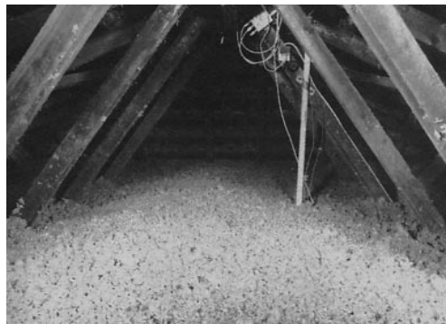
Abb. 18: z. B. mit eingeblasener Dämmung
