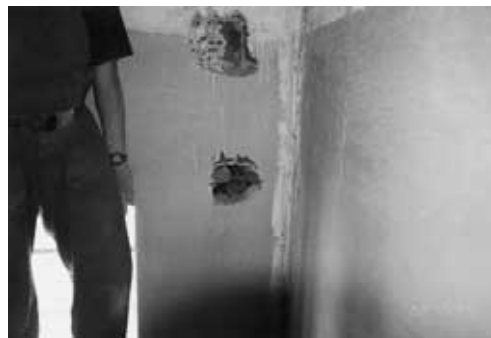
Das Foto zeigt hergestellte Öffnungen zur nachträglichen Kerndämmung im Innenwandbereich (z.B. bei denkmalgeschützten Gebäuden).
