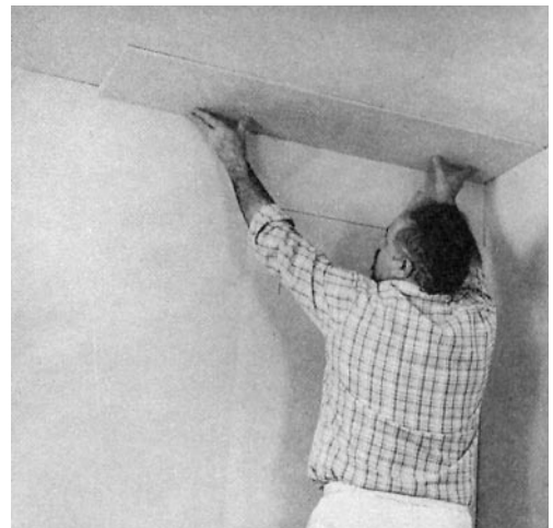
Dämmung einbindender Innenwände und Massivdecken mit einem Dämmkeil
