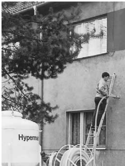
Das Bild zeigt, wie an einer Putzfassade durch gezielt gesetzte Öffnungen der Hyperlite-Dämmstoff eingeblasen wird.
