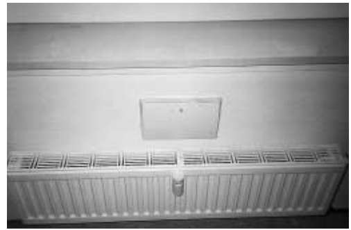
Das Zuluftelement sitzt bei diesem Gebäude beispielsweise oberhalb des Heizkörpers und lässt sich somit gut warten.
