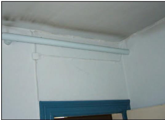
**Bild 56 großformatige Rohre der ehemaligen Schwerkraftheizung**
