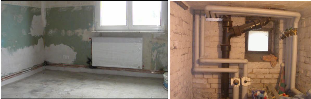
**Bild 36 Heiznetz im beheizten Bereich, Steigepunkt aller Netze im Keller**
