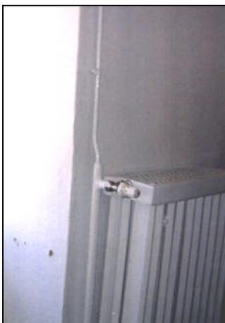
**Bild 64 Vorlaufleitung im Dachgeschoss mit Entlüftung zum oben liegenden Hochbehälter**
