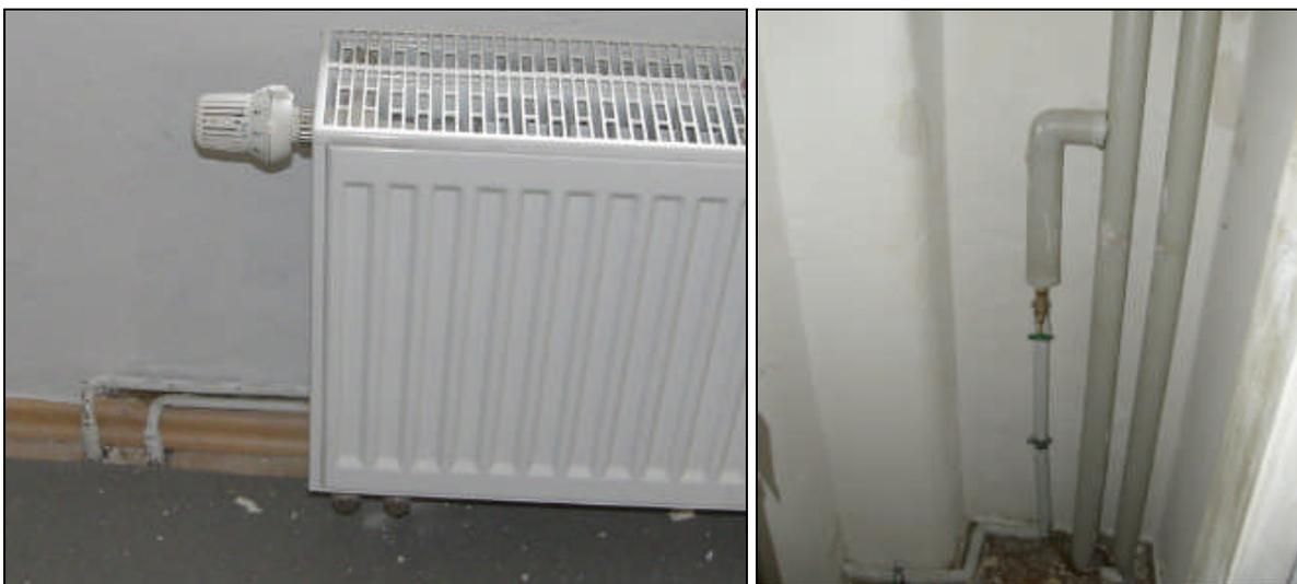
**Bild 43 Heizkörperanschluss und Abzweig der Stichleitung TWW im Obergeschoss**
