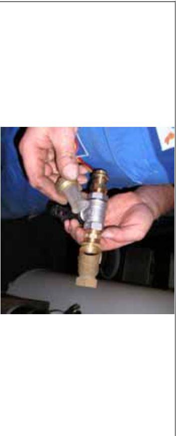
Abbildung 11 (N17) Filterunterteil und Filterelement vor dem Einbau
