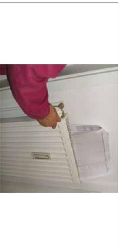
Abbildung 10 (N16) Aufsetzen des Kopfes auf das Ventil, nachdem der berechnete Voreinstellwert am Ventil eingestellt wurde
