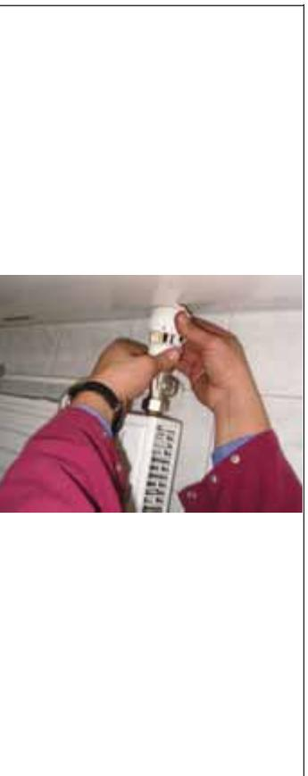
Abbildung 8 (N14) Der Thermostatkopf des vorhandenen Ventils wird abgenommen und das Ventil ausgebaut, da es nicht voreinstellbar ist
