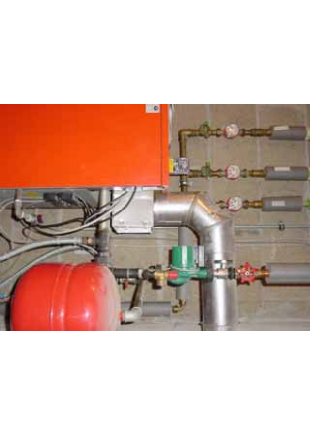
Abbildung 5 (N28) Externe Pumpe (grün) in einer größeren Heizungsanlage.
