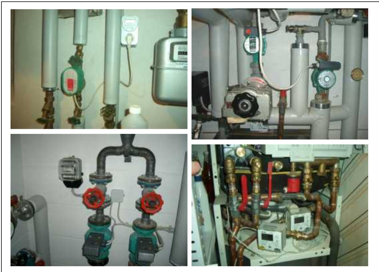
*Bild 7 Pumpen, Mischer, Zähleinrichtungen*
