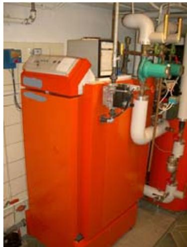
Hier zwei externe Pumpen in Parallelschaltung in Kombination mit einem Brennwertgerät.
